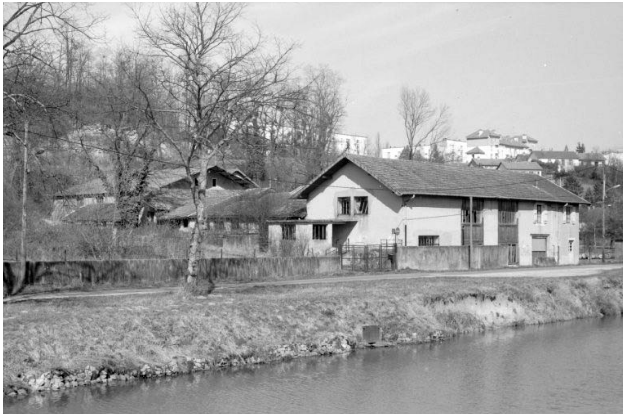
Ateliers de fabrication et logement d'ouvriers.
