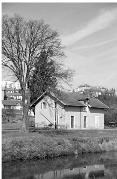
Bureau et logement d'ouvriers. Phot. Laurent Poupard IVR43_19893900311Z
