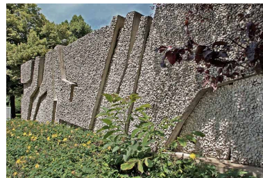
Vue de face, détail. Phot. Jean-Luc Duthu IVR26_20092100390NUC2A
