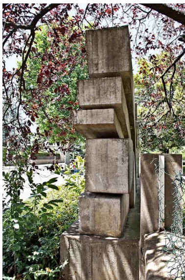
Vue de côté. Phot. Jean-Luc Duthu IVR26_20092100393NUC2A
