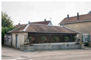
Vue générale. Phot. Jérôme Mongreville IVR43_20167001648NUC4A
