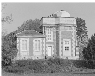
Façade ouest. Phot. Jérôme Mongreville IVR43_20022501165X
