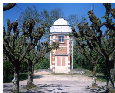
Tour de l'équatorial coudé, depuis le sud. Phot. Jérôme Mongreville IVR43_20022501243VA
