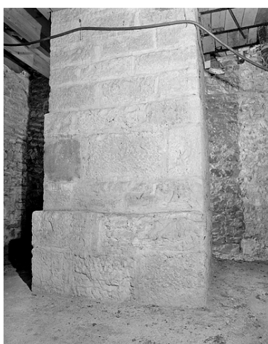
Sous-sol de la tour de l'équatorial coudé : vue d'ensemble rapprochée du pilier de la lunette. Phot. Jérôme Mongreville IVR43_20022501150X
