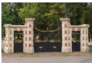
Entrée du parc. Phot. Pierre-Marie Barbe-Richaud IVR26_20205800560NUC4A
