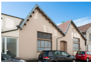
Murs-pignons des sheds sur le rue Klein. Phot. Jérôme Mongreville IVR43_20182500670NUC4A
