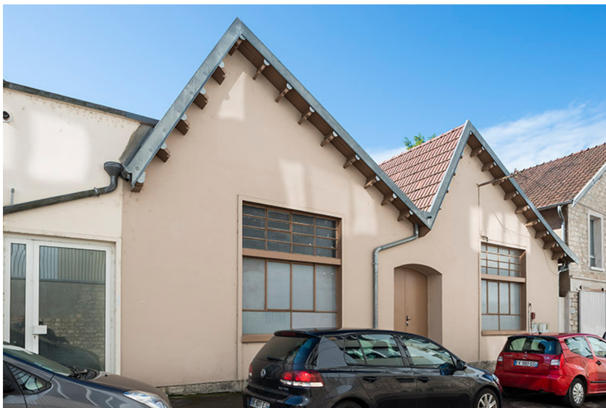
Murs-pignons des sheds sur le rue Klein.
