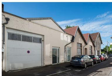
Façades postérieures (rue Klein). Phot. Jérôme Mongreville IVR43_20182500669NUC4A
