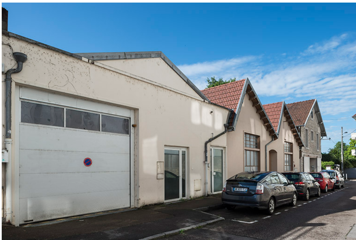
Façades postérieures (rue Klein).
