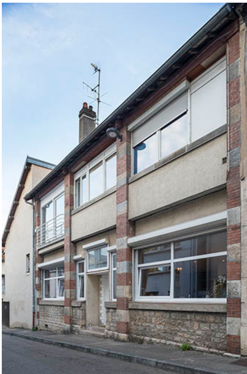
Façade antérieure vue de trois quarts droite.
