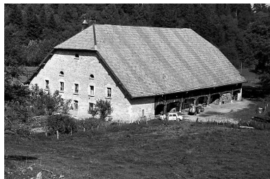
Vue générale. Phot. Bernard Lardière IVR43_19782500335X
