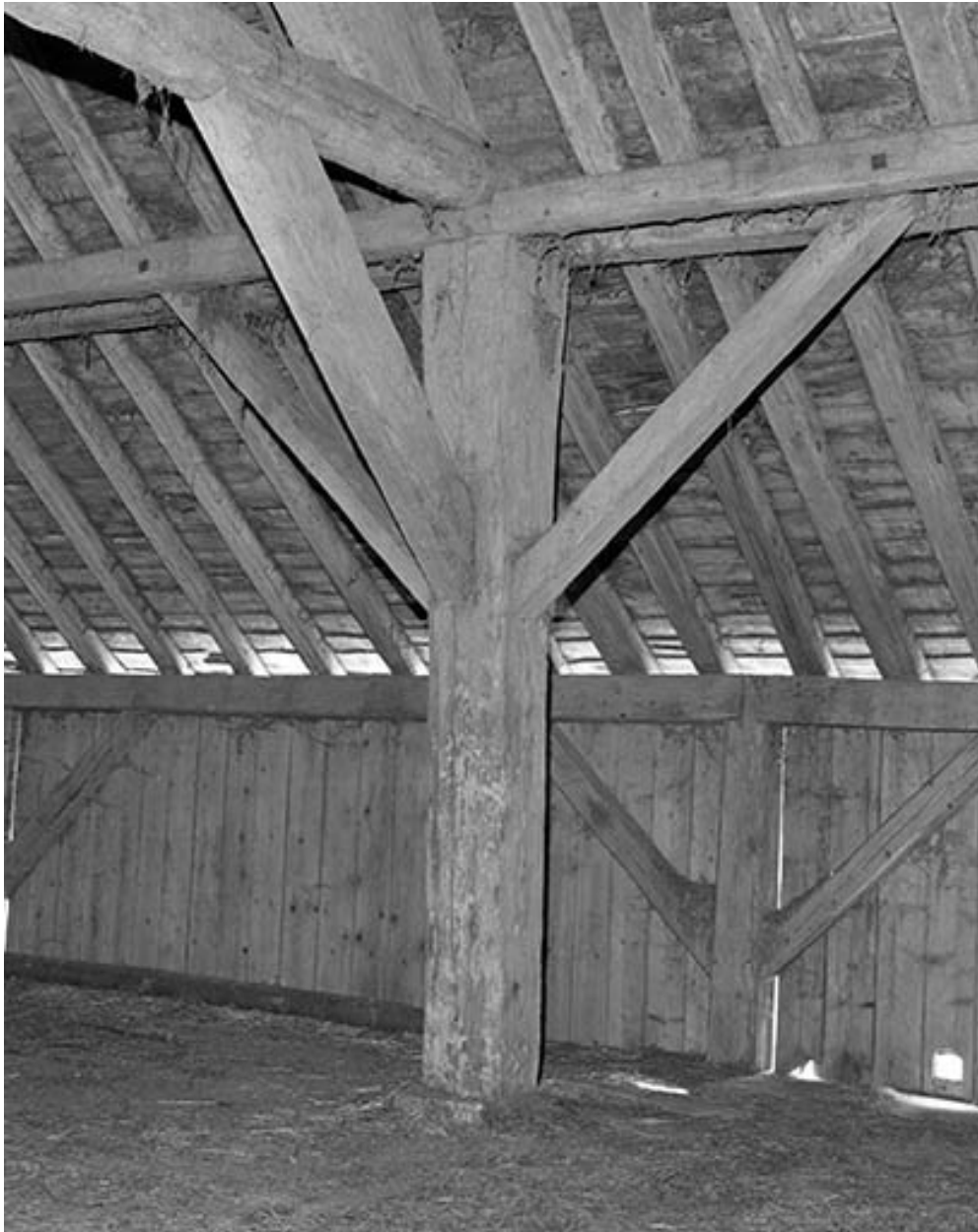
Charpente, partie inférieure au niveau d'une ferme.
