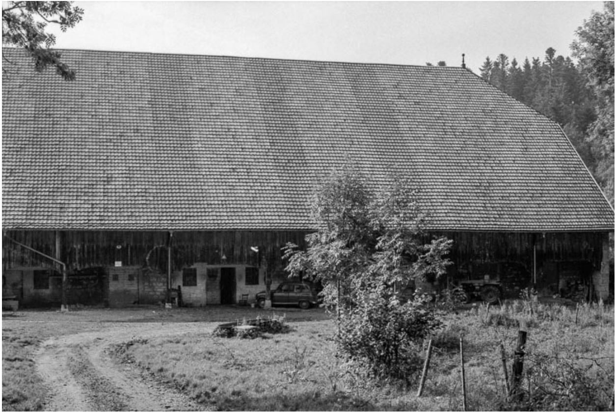
Façade latérale droite.
