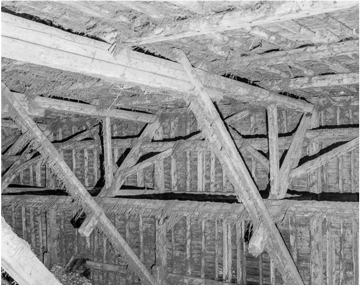
Charpente, partie supérieure.
