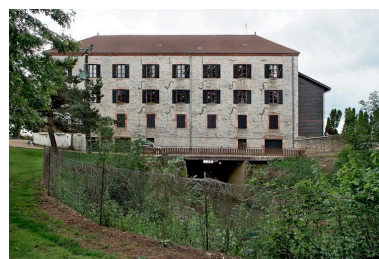
Vue de l'arrière du moulin avec le bief qui l'alimentait. Phot. Jean-Luc Duthu IVR26_20107100505NUC2A
