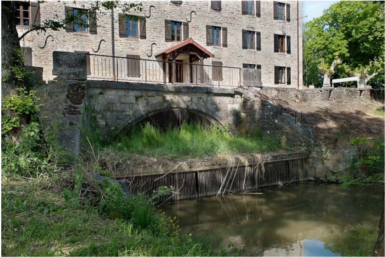
Vue de l'avant du moulin avec le bief qui l'alimentait.
