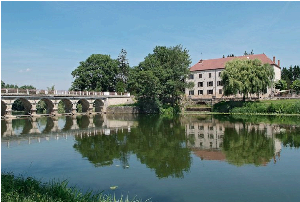
Barrage et pont de La Truchère à gauche, moulin à droite, vus de la rive droite de la Seille.
