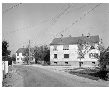
Immeubles semblables, rue Victor Hugo. Phot. Yves Sancey IVR43_19893900572X
