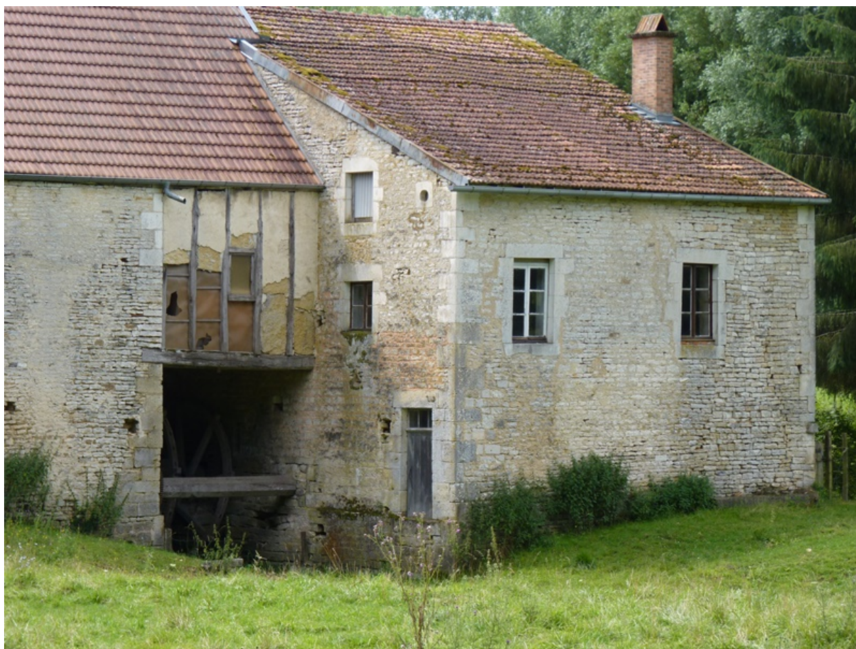
Détail de la jonction entre les deux parties du moulin (élévation nord).
