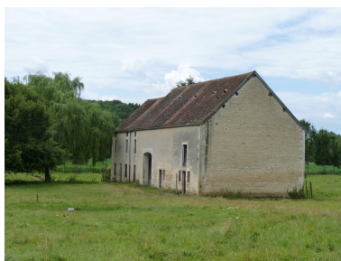
Vue du moulin depuis l'est. Phot. Baptiste Quost IVR26_20162100646NUC2A
