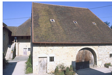
Les parties agricoles situées dans la cour. Phot. Yves Sancey IVR43_19857000053XA
