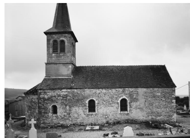
Elévation gauche. Phot. Michel Thierry IVR26_19782100861V
