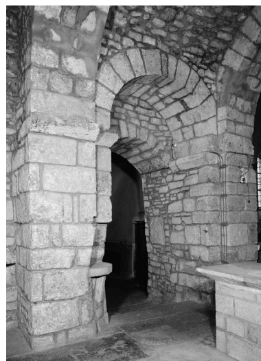
Entrée de la chapelle. Phot. Michel Thierry IVR26_19782100869V
