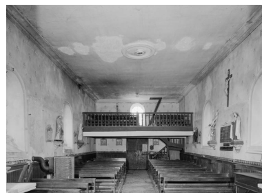
La nef, depuis le chœur. Phot. Michel Thierry IVR26_19782100866V
