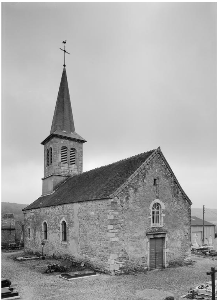
Vue d'ensemble de 3/4 gauche.
