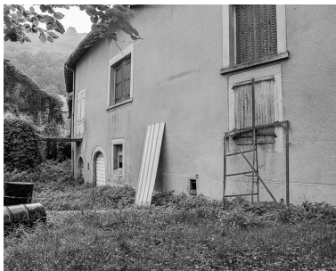
Face postérieure. Phot. Yves Sancey IVR43_19843900251X
