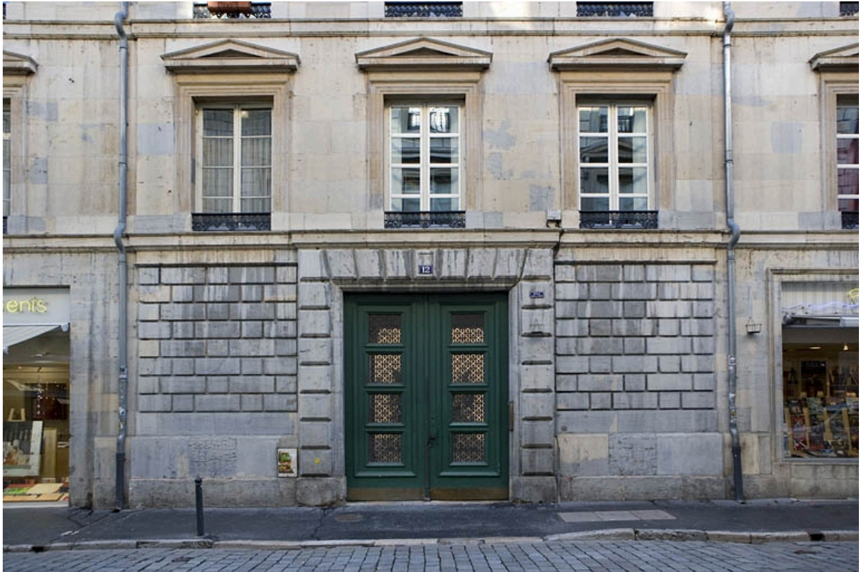
Détail du portail d'entrée, de face.
