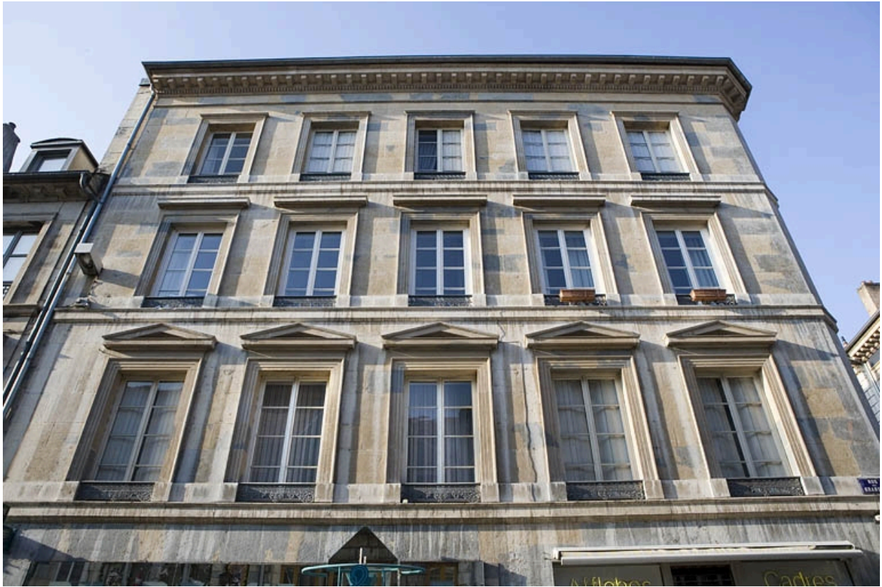
Détail de la façade située rue des Granges, de face.
