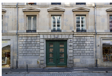
Détail du portail d'entrée, de face. Phot. Yves Sancey IVR43_20082500359NUC2A
