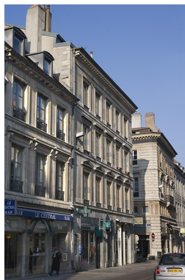
Vue d'ensemble de l'immeuble depuis la rue des Granges, de trois quarts gauche. Phot. Yves Sancey IVR43_20082500352NUC2A
