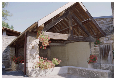
Vue extérieure. Phot. Jacques Druart IVR26_19967100847ZA
