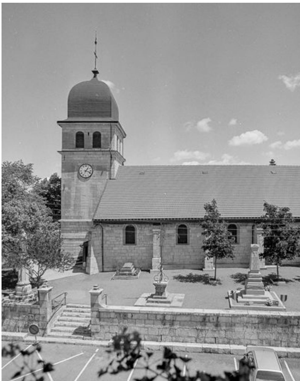
Façade latérale droite.
