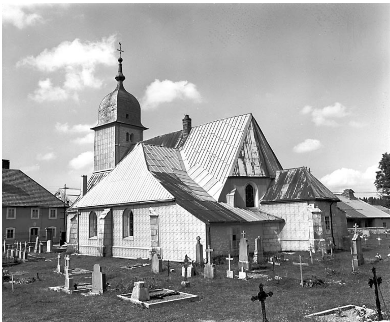
Façades postérieure et latérale droite.
