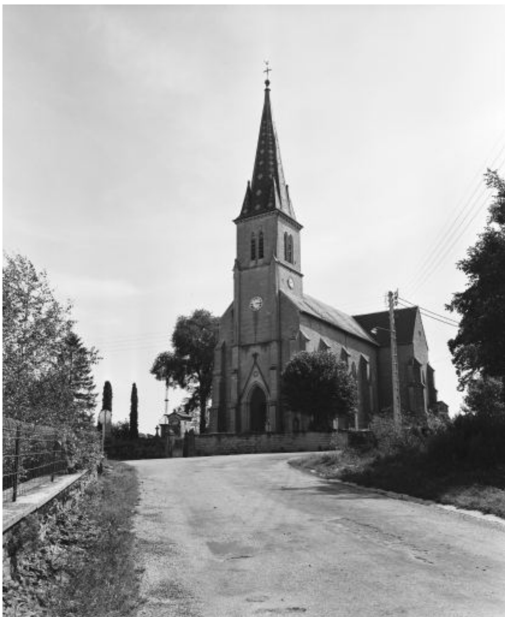
Façades antérieure et latérale droite.
