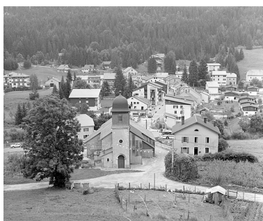
Vue de situation depuis l'ouest (vue horizontale). Phot. Yves Sancey IVR43_19963900914X
