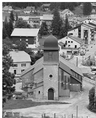
Façade ouest. Phot. Yves Sancey IVR43_19963900913X
