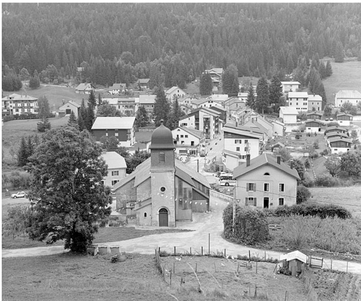
Vue de situation depuis l'ouest (vue horizontale).
