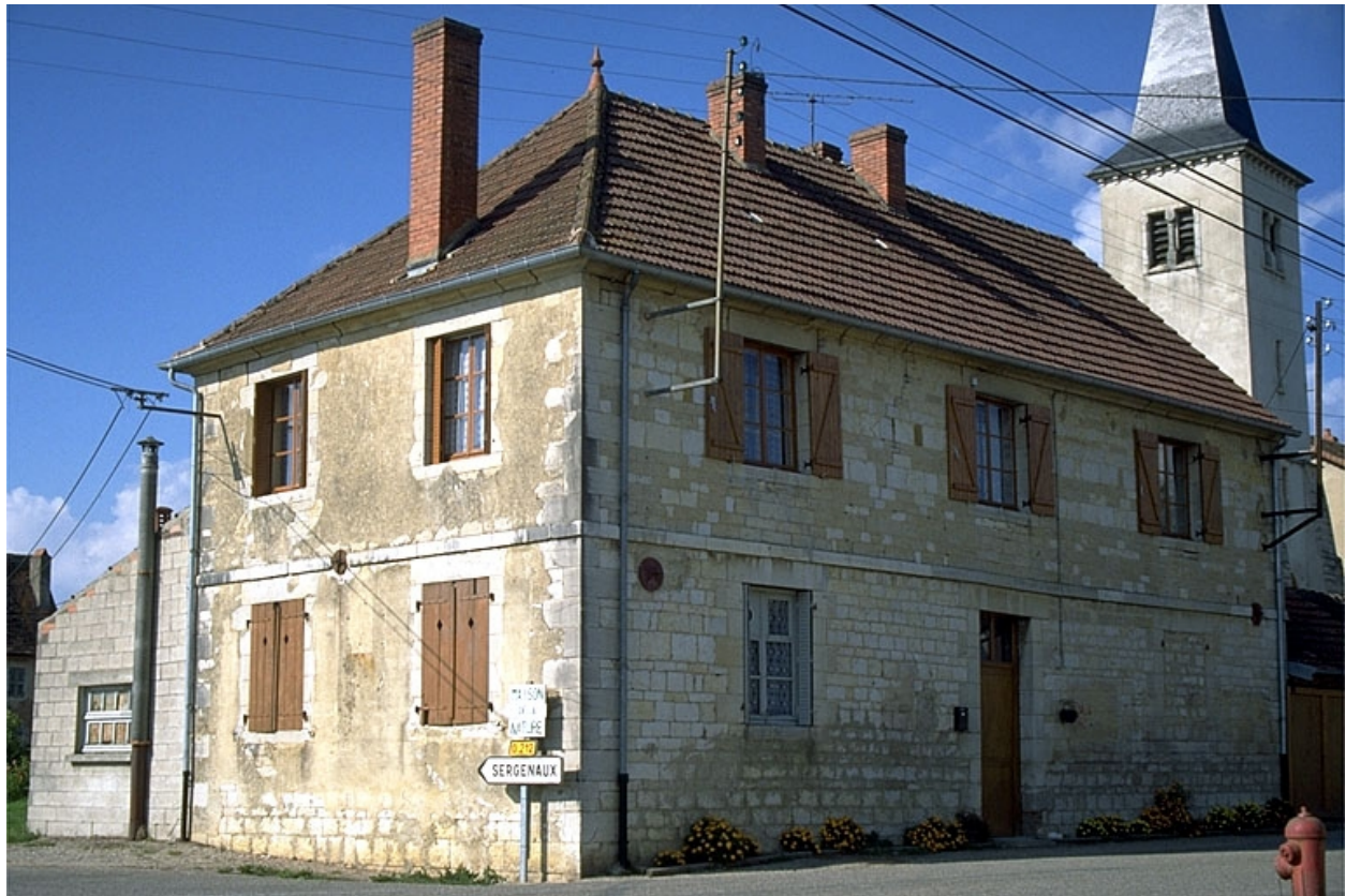
Ancienne école, vue de trois quarts gauche.
