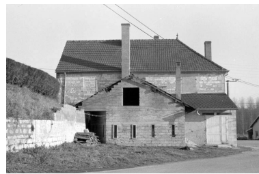
Chambre à lait, depuis l'ouest. Phot. Laurent Poupard IVR43_19893900081Z
