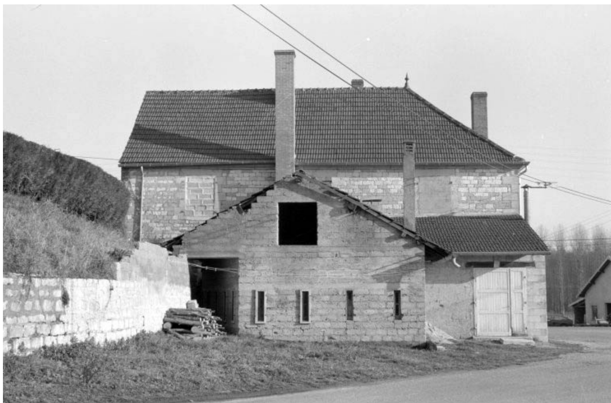
Chambre à lait, depuis l'ouest.
