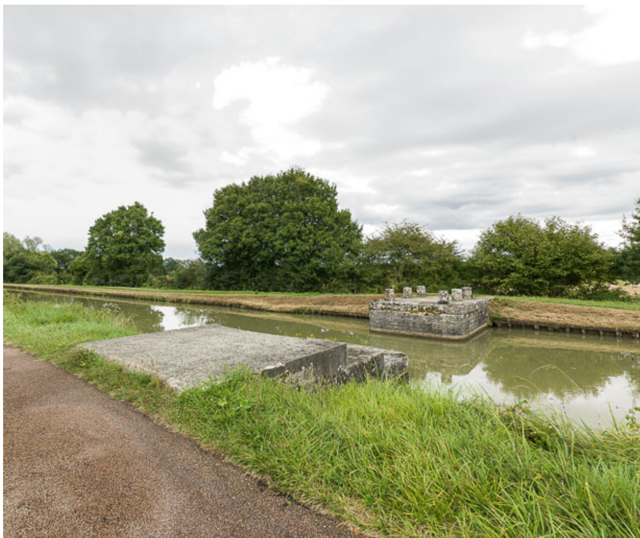
VUe des vestiges du pont.
