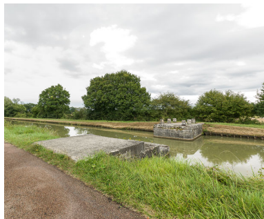
VUE des vestiges du pont.
