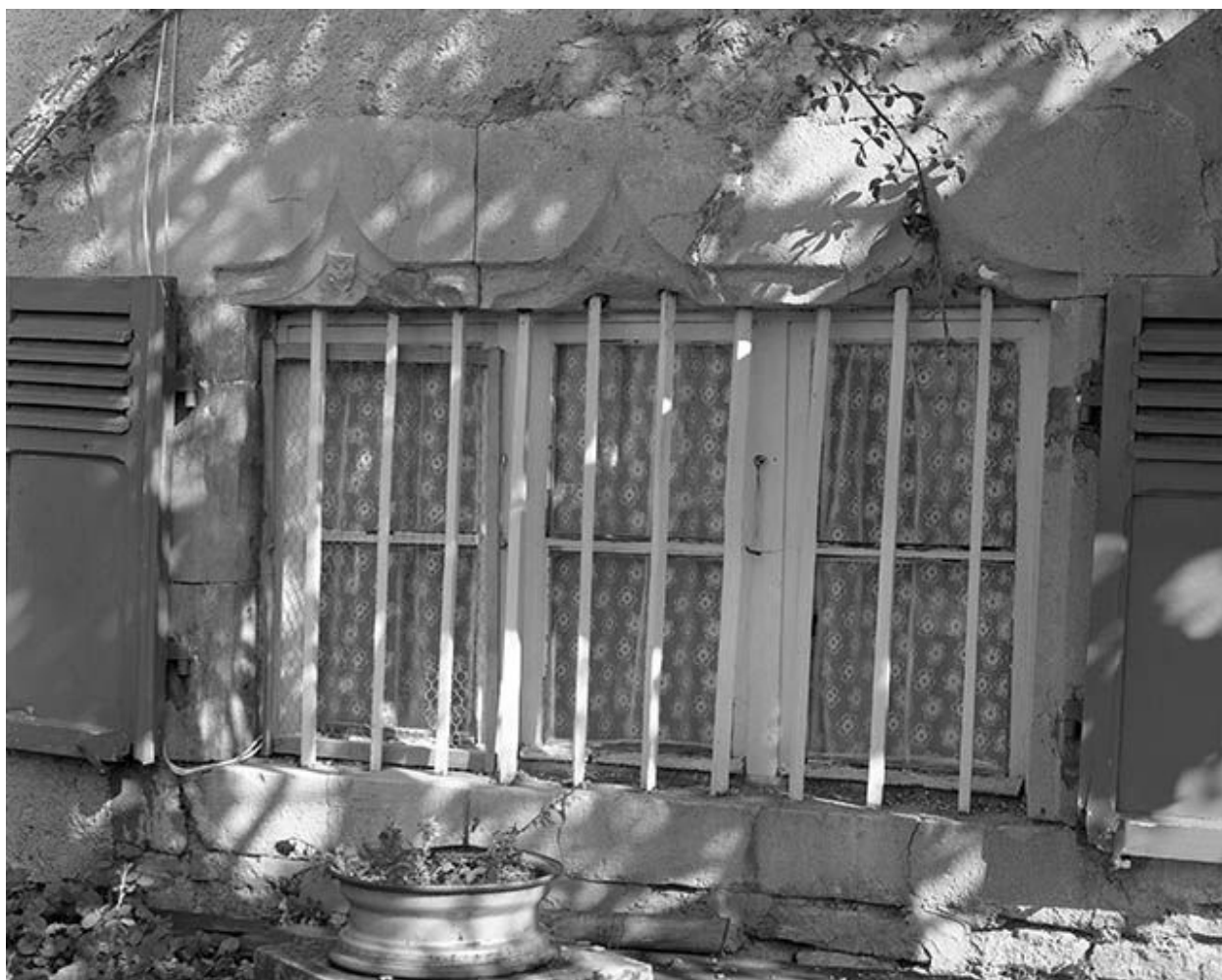
Façade postérieure : baie du rez-de-chaussée.
