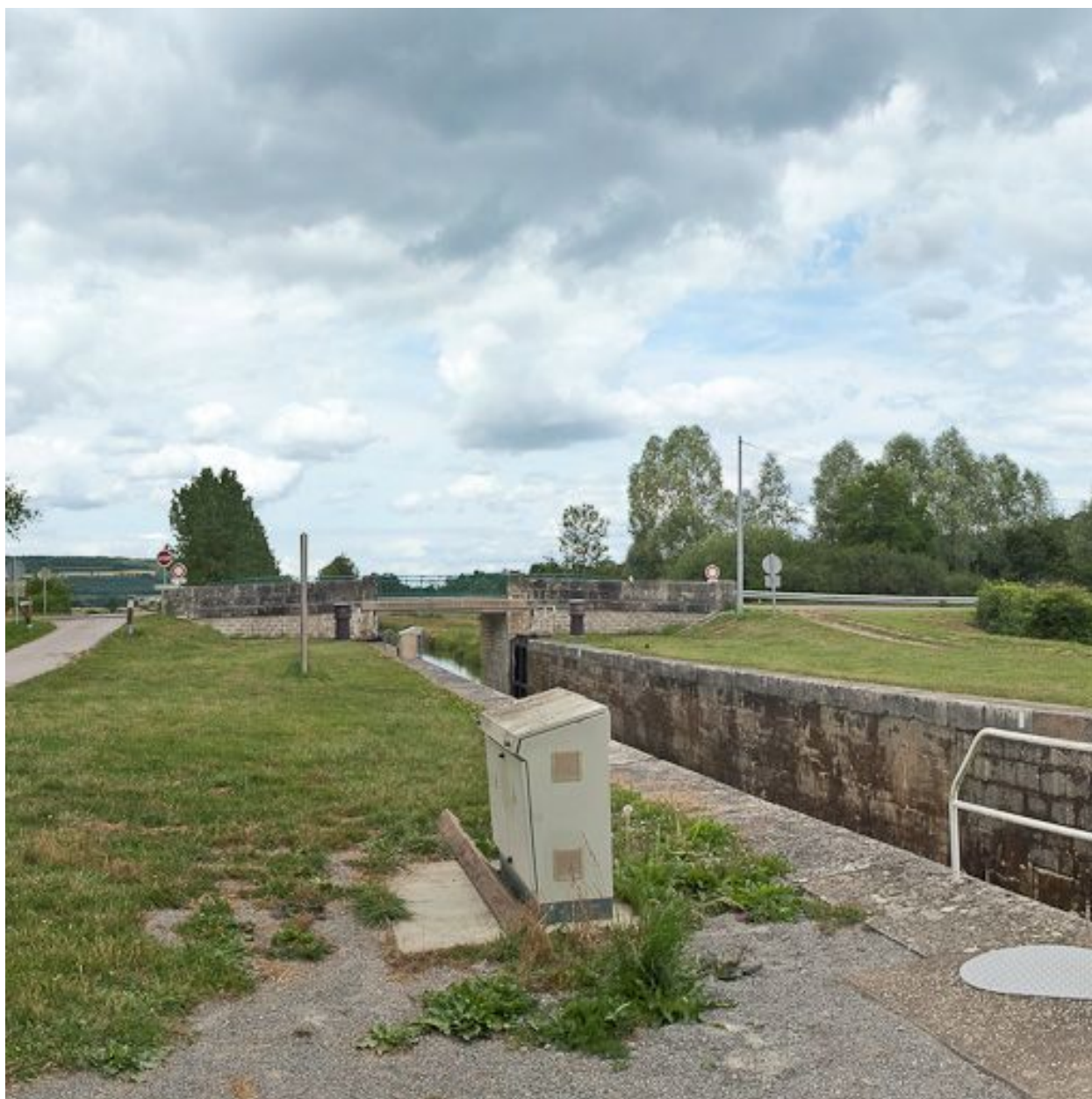
Vue du pont depuis l'amont.
