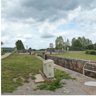
Vue du pont depuis l'amont. Phot. Pierre-Marie Barbe-Richaud IVR26_20112103723NUC2AQ
