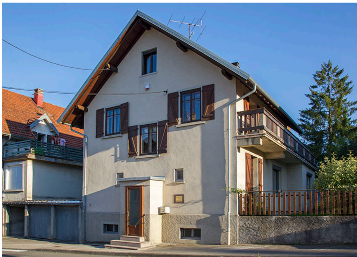
Façades antérieure et latérale droite.
