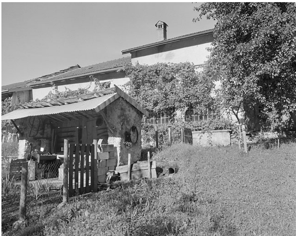
Façade postérieure de l'atelier.
