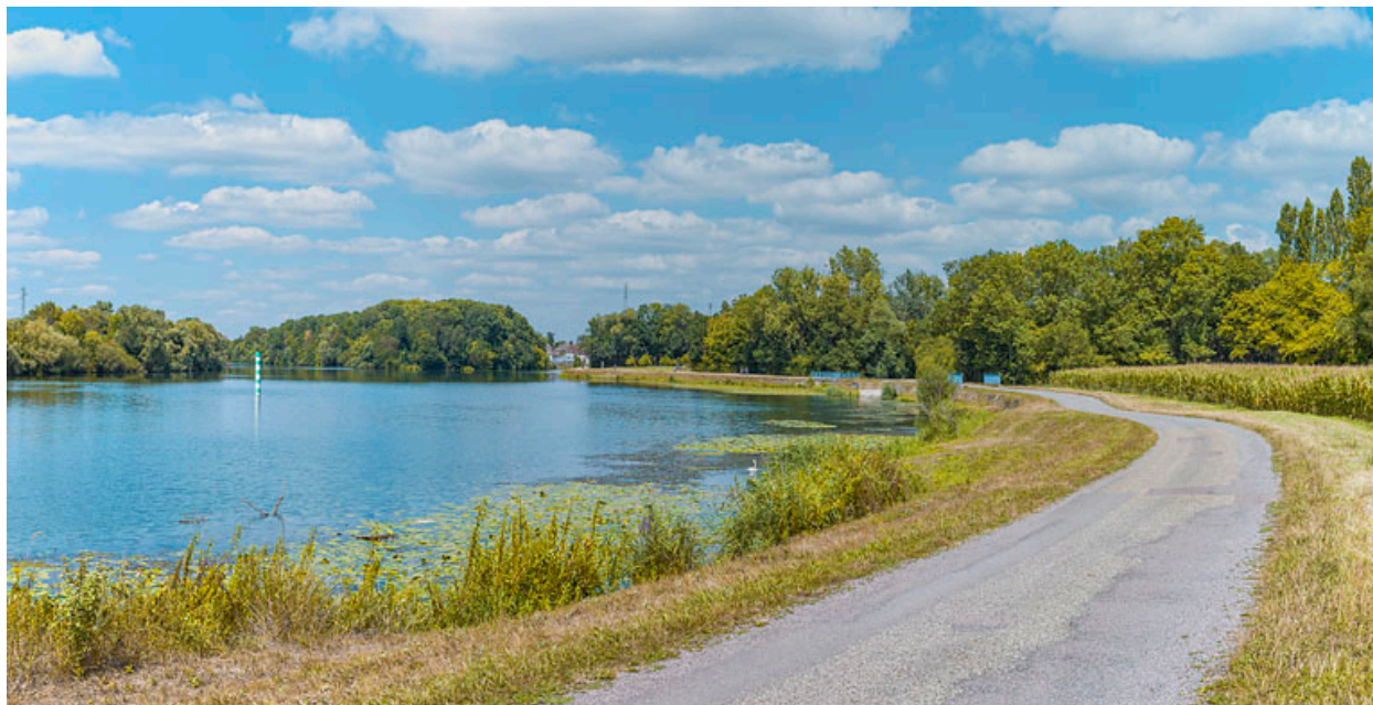
Vue d'ensemble, d'aval.
