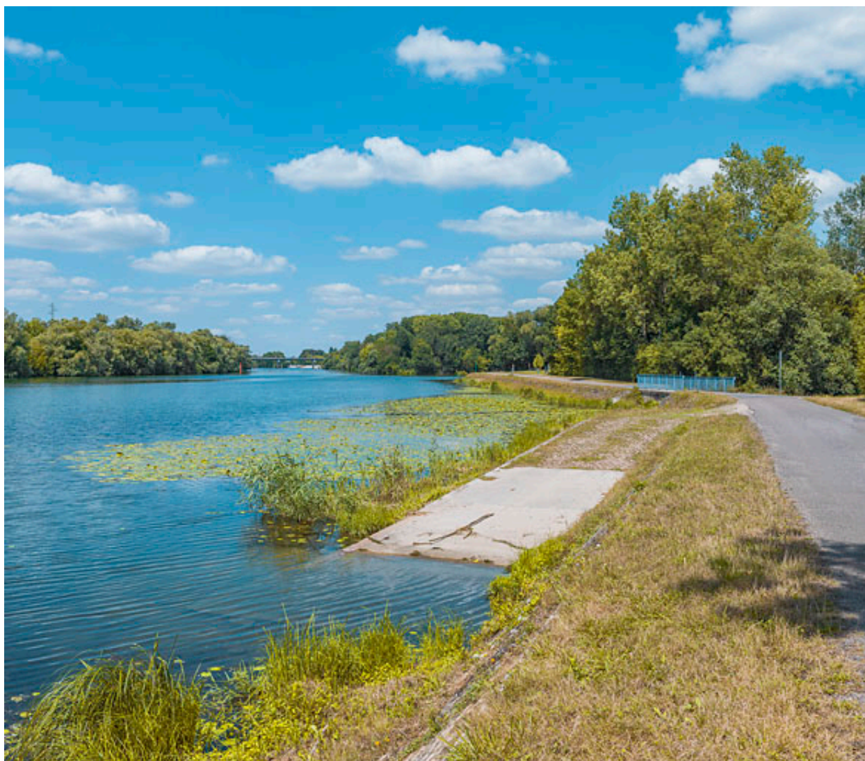
La rampe d'abreuvoir et les perrés.
