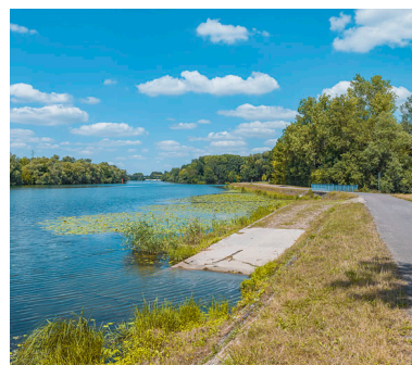
La rampe d'abreuvoir et les perrés. Phot. Thierry Kuntz IVR26_20192100168NUC4A
