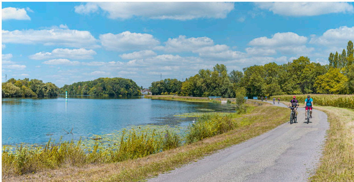
Vue d'ensemble d'aval des aménagements de rive à hauteur de Jallanges. En arrière-plan, la ville de Seurre.
