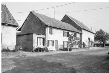
Ferme située Grande Rue. Phot. Bernard Lardière IVR43_19832500117Z
