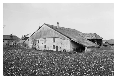
Ferme située route de Salins : vue d'ensemble. Phot. Dominique Dominguez IVR43_19792500162X
