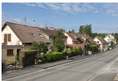
Logements d'ouvriers. Phot. Jérôme Mongreville IVR43_20122501861NUC4A
