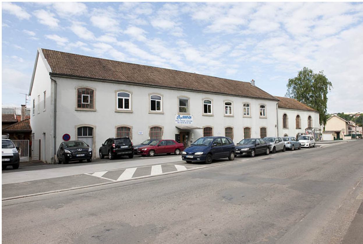
Bâtiment administratif (?) longeant le faubourg de Besançon.
