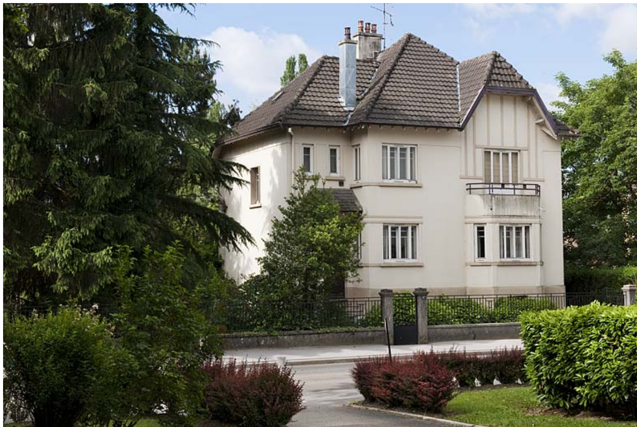
Logement patronal. Vue de trois quarts.
