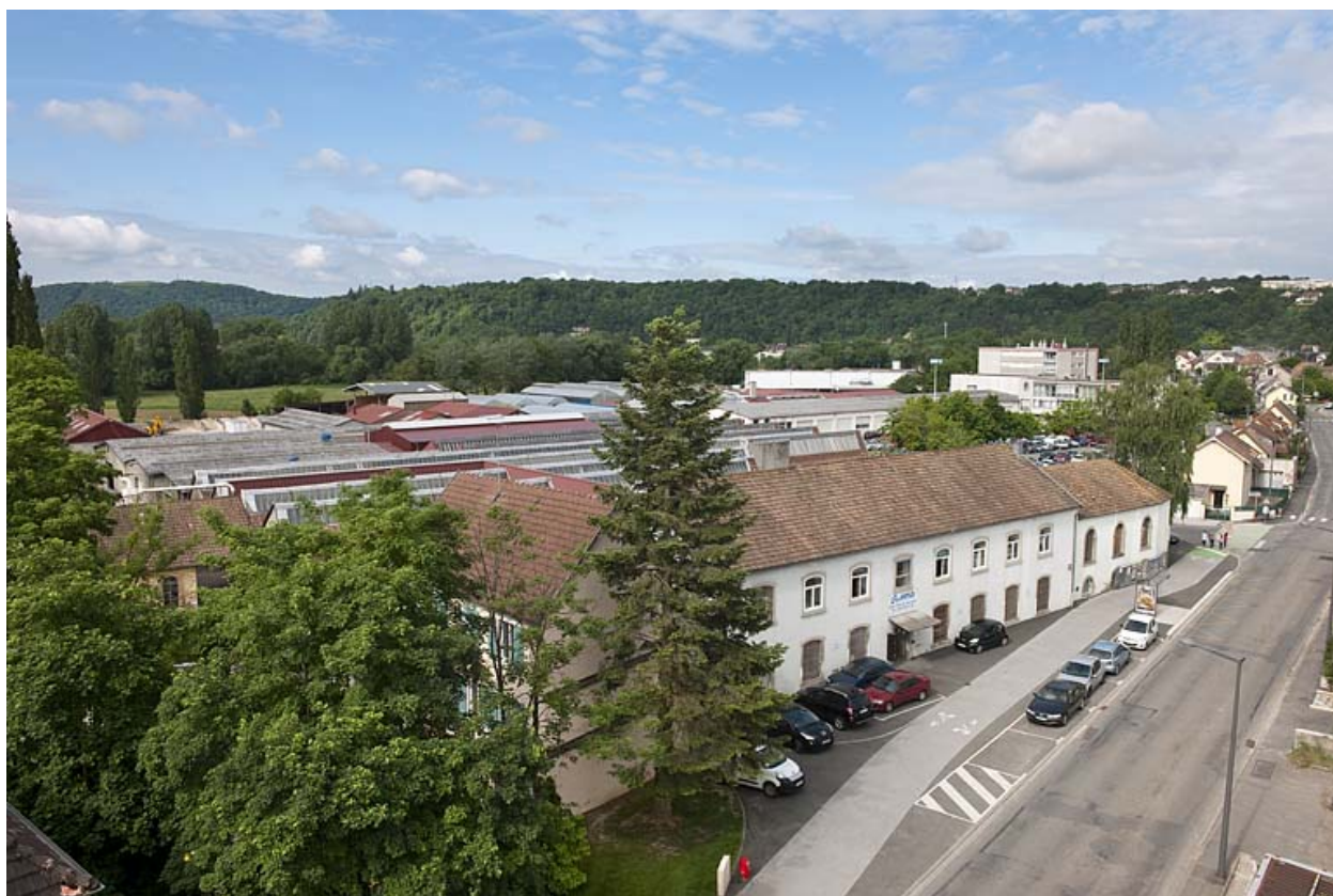
Vue plongeante depuis le nord-est.
