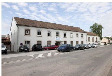
Bâtiment administratif (?) longeant le faubourg de Besançon. Phot. Jérôme Mongreville IVR43_20122500956NUC4A
