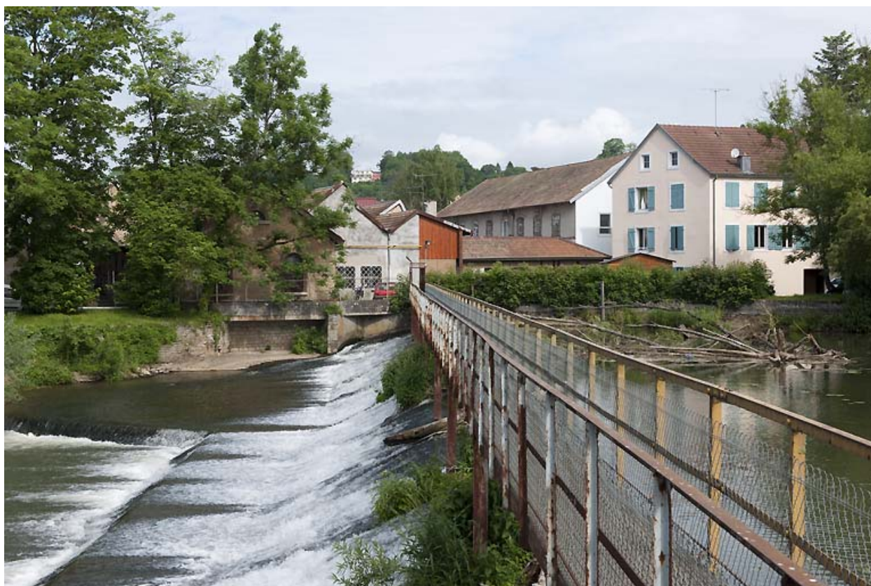
Vue d'ensemble depuis l'extrémité sud du barrage.
