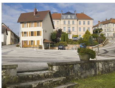
Vue générale depuis la poste. Phot. Jérôme Mongreville IVR43_20082501120NUC2A
