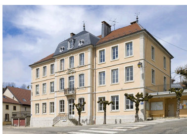
Façade antérieure et façade latérale droite. Phot. Jérôme Mongreville IVR43_20092500495NUC2A
