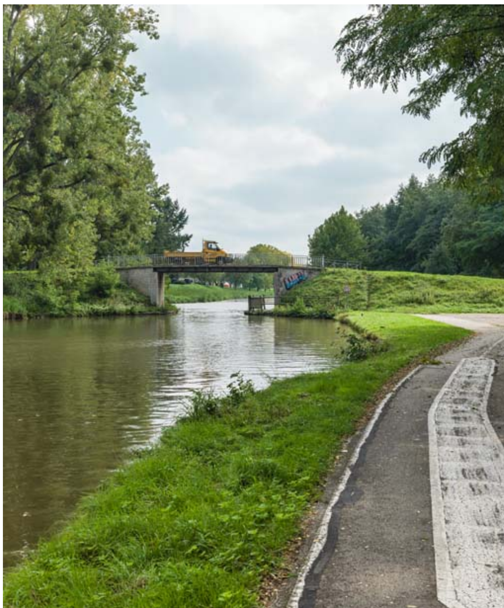
Vue d'ensemble du pont.
