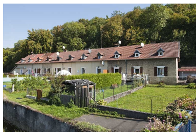
Logement nord (caserne A) depuis l'ouest. Phot. Jérôme Mongreville IVR43_20112502415NUC4A
