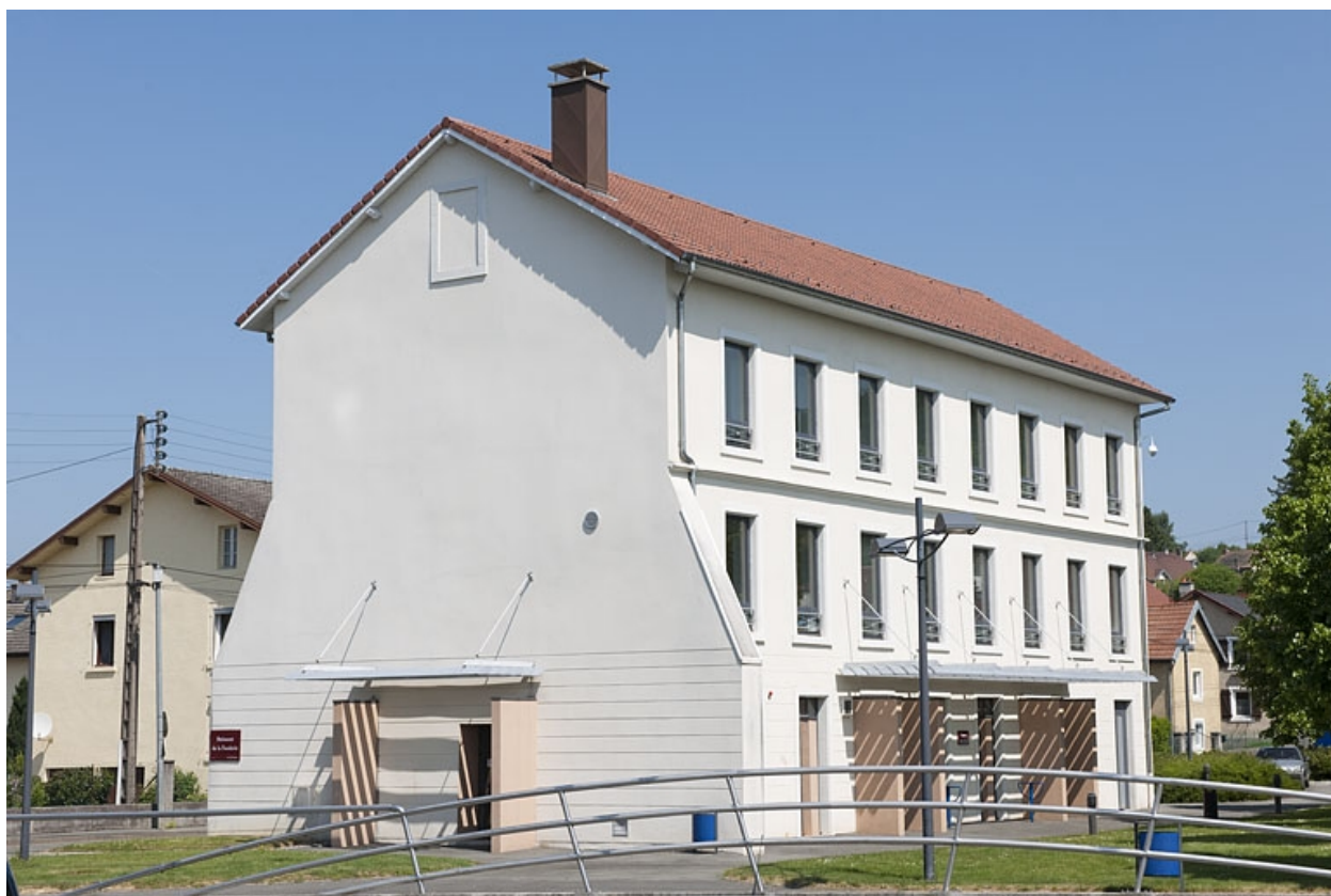
Bâtiment de bureaux. Vue trois quarts arrière.
