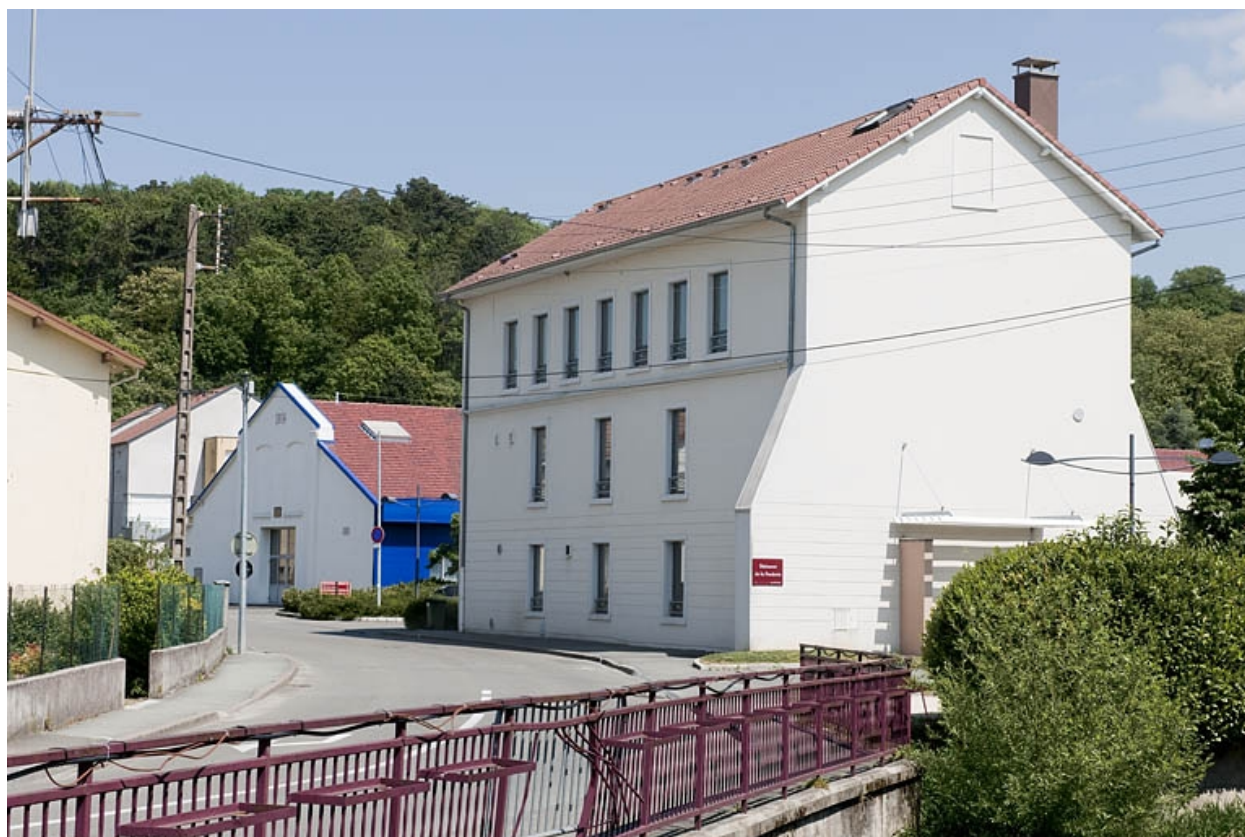
Bâtiment de bureaux. Vue depuis le pont.
