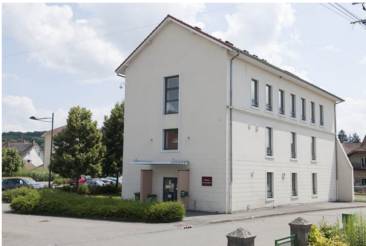
Bâtiment de bureaux. Vue depuis le nord.
