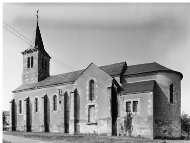
Elévation gauche. Phot. non renseigné IVR26_19755800211V
