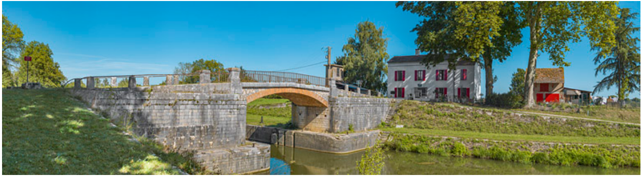
Vue d'ensemble du site avec le pont sur écluse vu d'aval.
