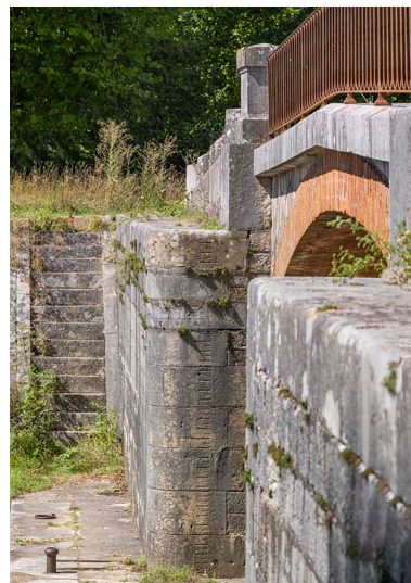
Détail de la voûte en brique, du garde-corps du pont et de l'échelle de crue sur la culée.
