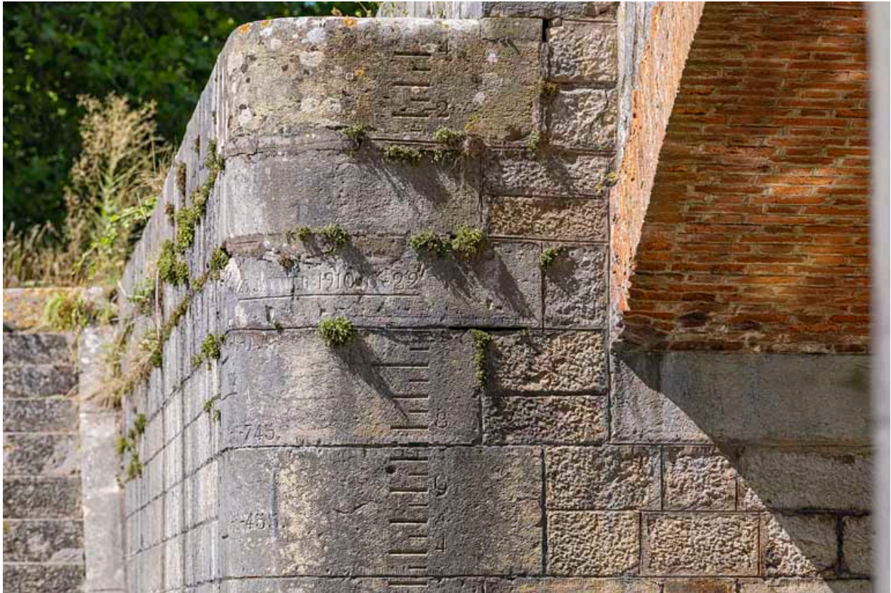
Détail de la voûte en brique et de l'échelle de crue sur la culée.
