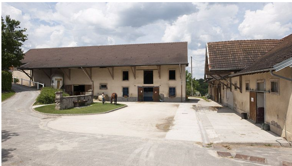
Cour de la ferme et bâtiments agricoles.
