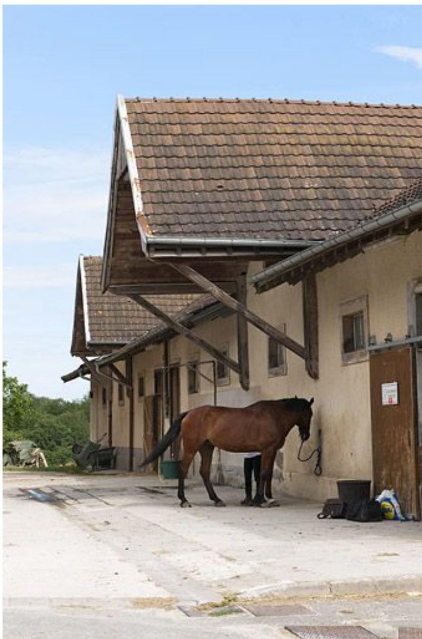
Ancienne étable. Vue de trois quarts.
