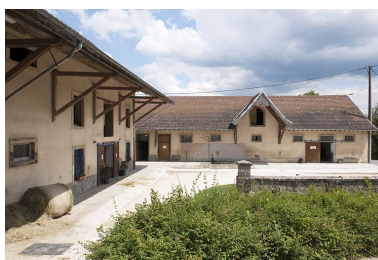
Bâtiments agricoles depuis le sud. Phot. Jérôme Mongreville IVR43_20112501621NUC4A
