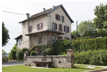
Logement d'origine vu de trois quarts. Phot. Jérôme Mongreville IVR43_20112501616NUC4A
