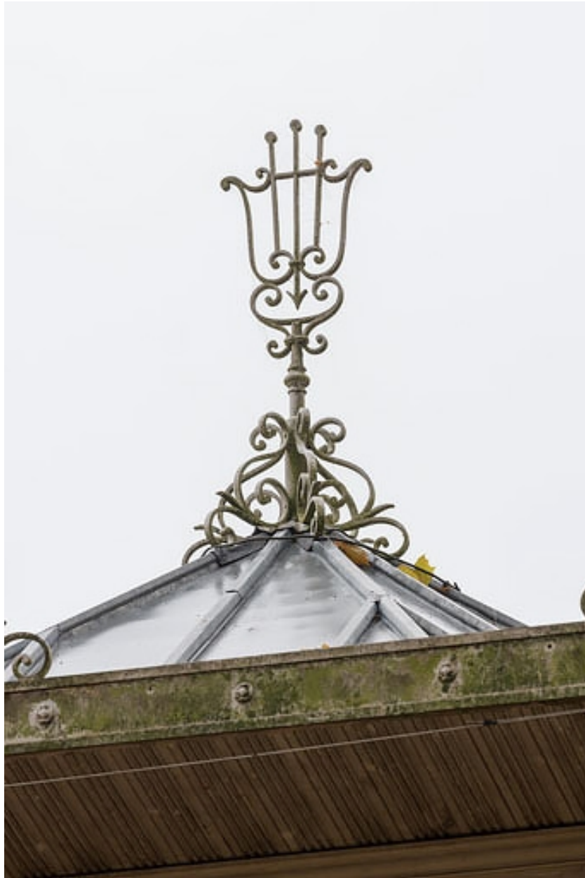
Epi de faitage en forme de lyre.
