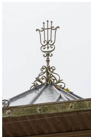
Epi de faitage en forme de lyre. Phot. Pierre-Marie Barbe-Richaud IVR26_20212100355NUC4A
