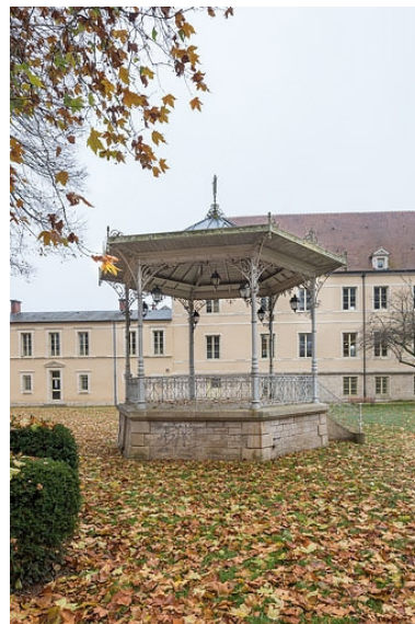
Elévation latérale gauche. Phot. Pierre-Marie Barbe-Richaud IVR26_20212100352NUC4A
