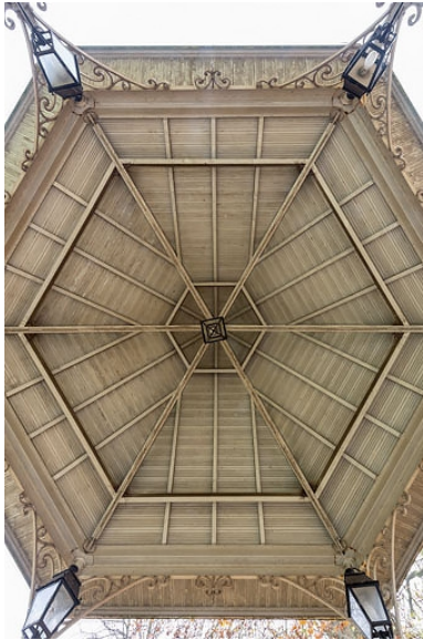
Face inférieure du toit.
