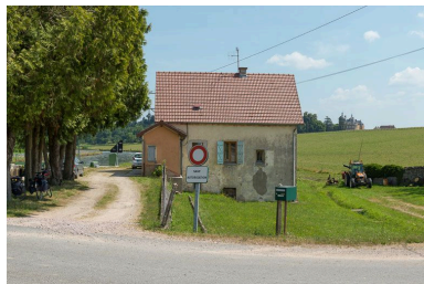
Façade latérale de la maison éclusière. On devine le château de Digoine en arrière-plan.
