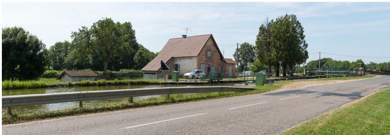
Vue d'ensemble avec la maison éclusière et le pont sur écluse.
