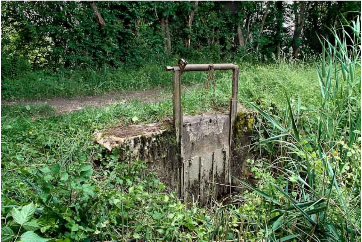
Vue rapprochée de la vanne de l'aqueduc.
