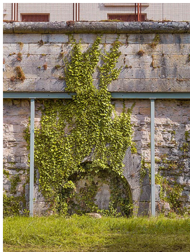
Le mur d'escarpe étayé (détail). Phot. Thierry Kuntz IVR26_20232100174NUC4A
