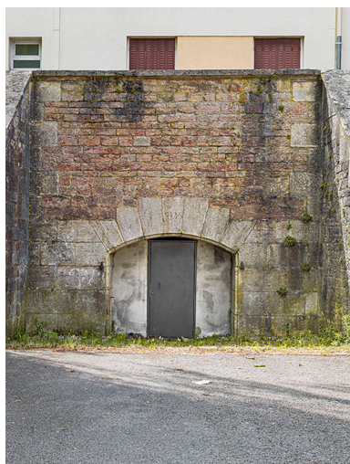
La poterne (détail). Phot. Thierry Kuntz IVR26_20232100172NUC4A
