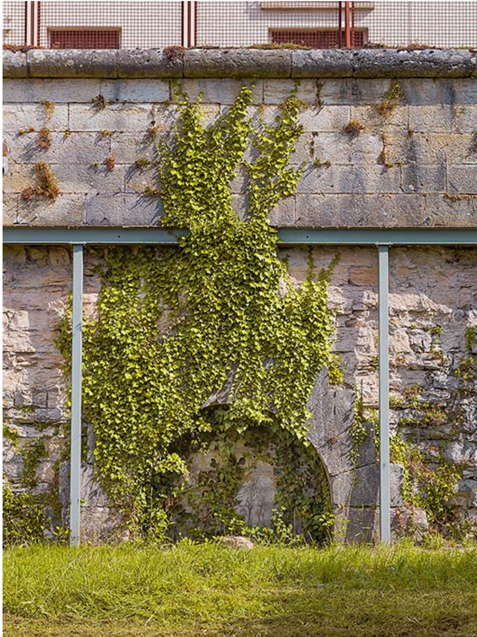
Le mur d'escarpe étayé (détail).
