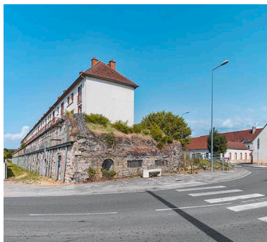
La courtine reliait à cet endroit l'ancien bastion Notre-Dame. Phot. Thierry Kuntz IVR26_20232100458NUC4A
