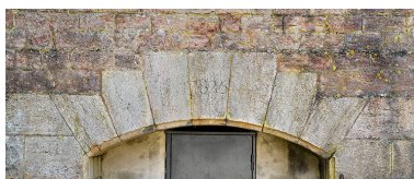
Date portée de la poterne. Phot. Thierry Kuntz IVR26_20232100173NUC4A
