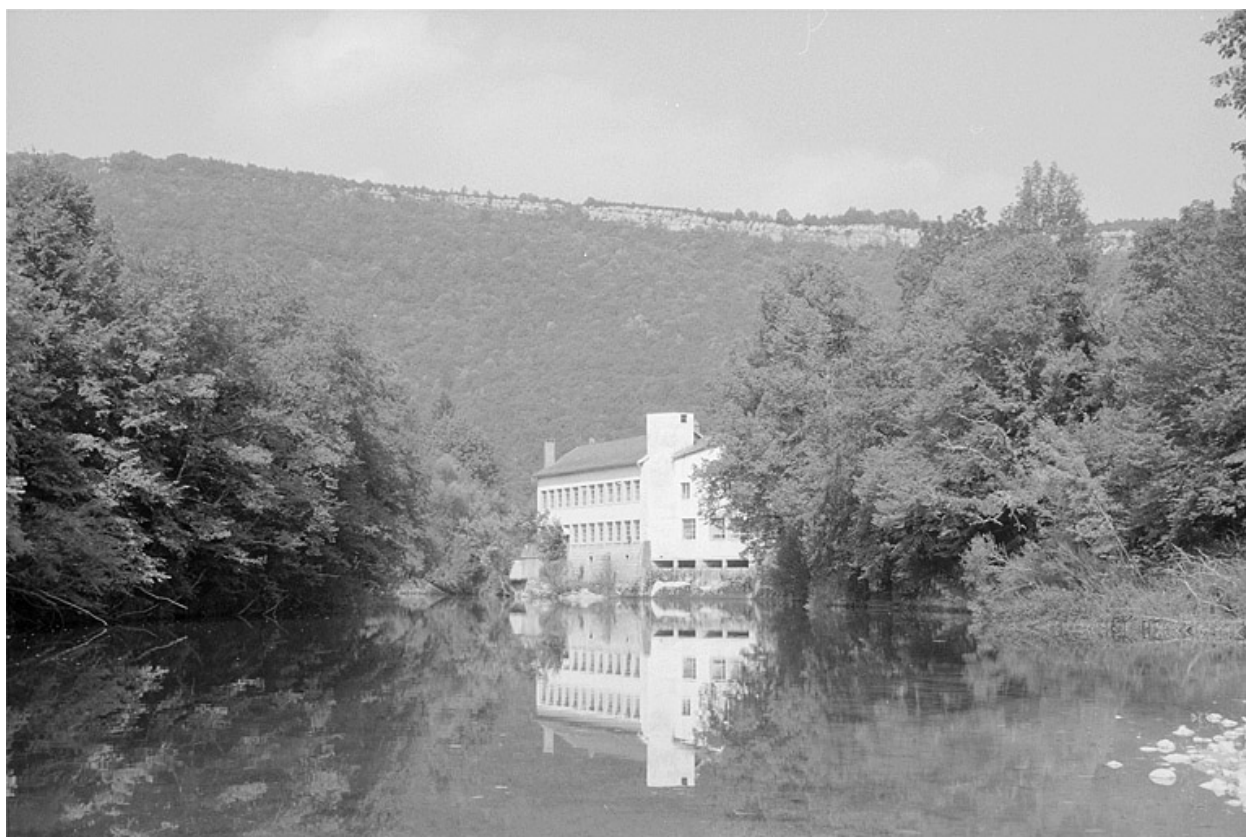
Vue d'ensemble, depuis le sud-est (amont).
