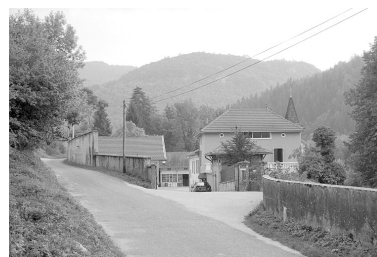
Entrée de l'usine et logement patronal. Phot. Laurent Poupard
