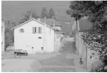
Bureau désaffecté et logement de contremaître. Phot. Laurent Poupard IVR43_19903900491Z
