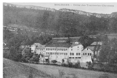
Molinges - Usine des Tourneries Chevassu. Phot. Jérôme Mongreville IVR43_19903900319X
