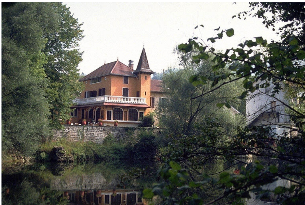
Logement patronal, depuis l'ouest.
