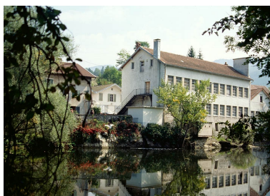
Atelier de fabrication, depuis le nord-ouest (aval).
