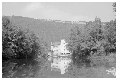
Vue d'ensemble, depuis le sud-est (amont).
