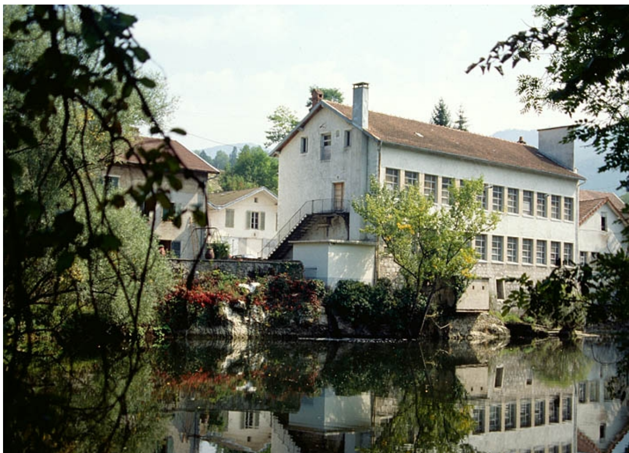
Atelier de fabrication, depuis le nord-ouest (aval).
