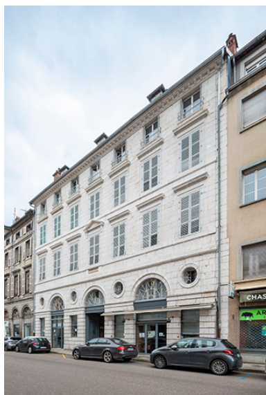
Façade antérieure vue de trois quarts droite. Phot. Jérôme Mongreville IVR43_20243901031NUC4A
