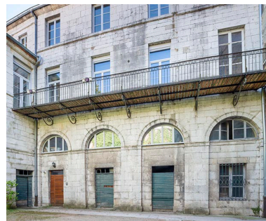
Façade de l'aile sud, depuis la cour. Phot. Jérôme Mongreville IVR43_20233900814NUC4A
