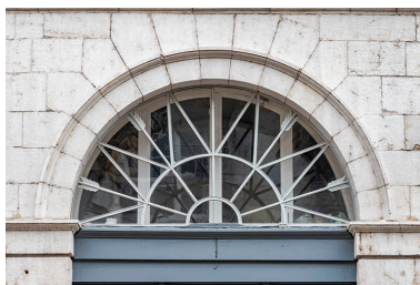
Détail des arcades en plein-cintre des grandes baies (niveau de l'entresol). Phot. Jérôme Mongreville IVR43_20243901073NUC4A
