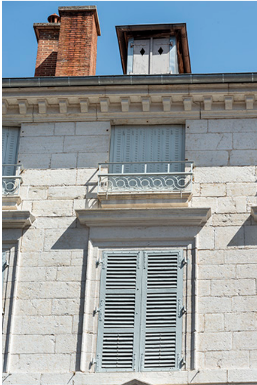
Façade antérieure. Fenêtres des étages supérieurs.
