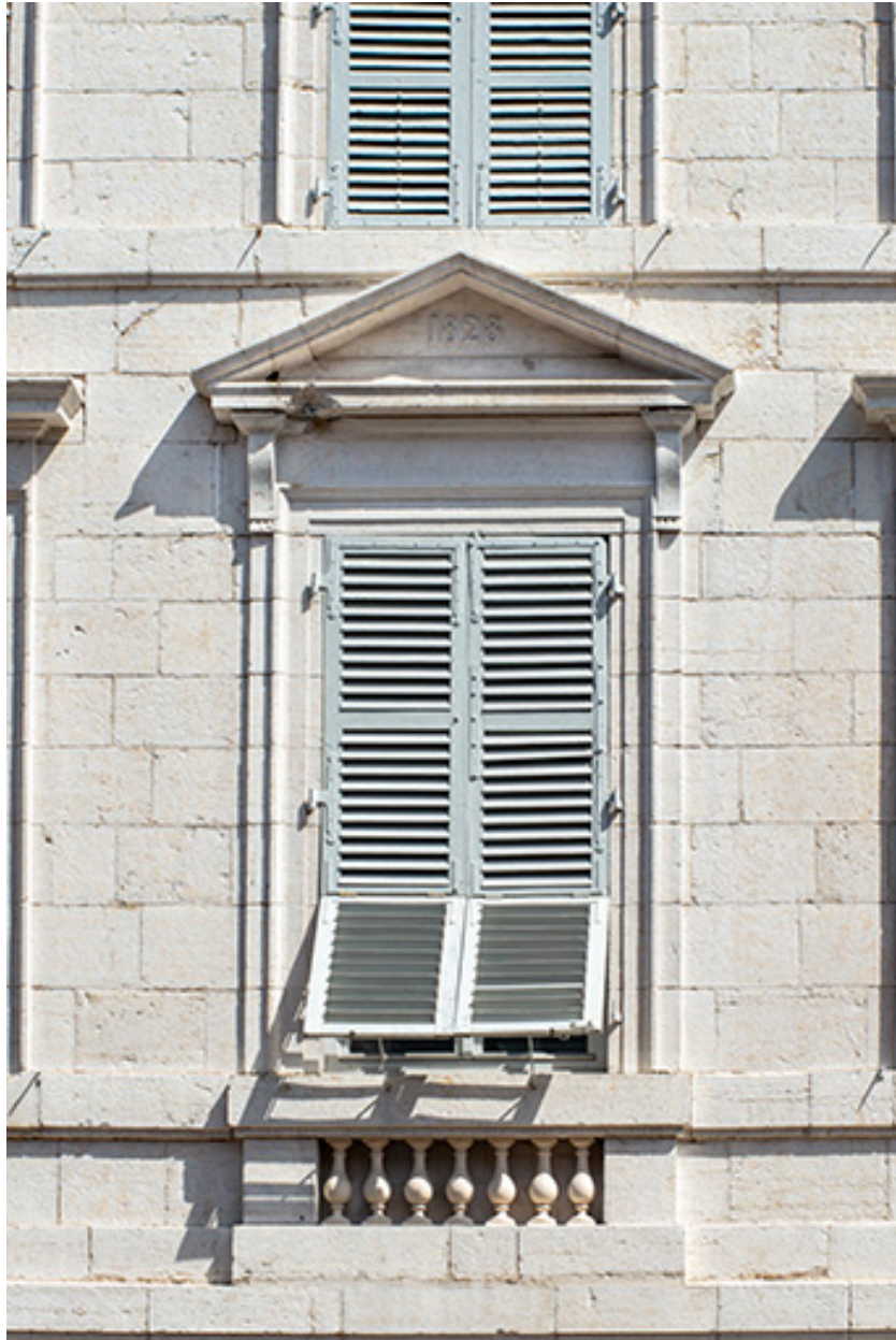
Fenêtre centrale du premier étage.
