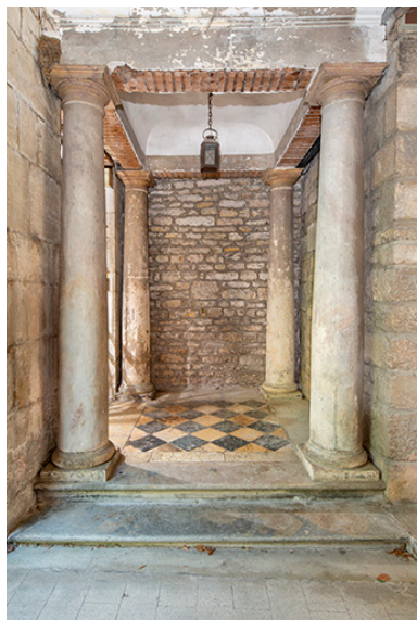
Rez-de-chaussée de l'allée cochère. Vestibule de la cage d'escalier. Phot. Jérôme Mongreville IVR43_20233900812NUC4A
