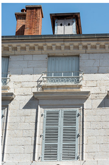
Façade antérieure. Fenêtres des étages supérieurs. Phot. Jérôme Mongreville IVR43_20233900810NUC4A
