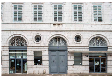
Travées centrales du rez-de-chaussée. Phot. Jérôme Mongreville IVR43_20243901072NUC4A
