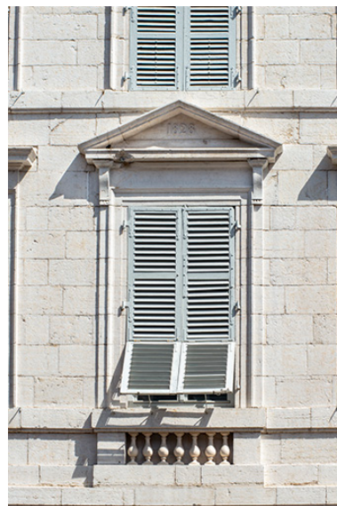
Fenêtre centrale du premier étage. Phot. Jérôme Mongreville IVR43_20233900808NUC4A
