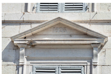
Fronton de la fenêtre centrale du premier étage. Phot. Jérôme Mongreville IVR43_20233900807NUC4A
