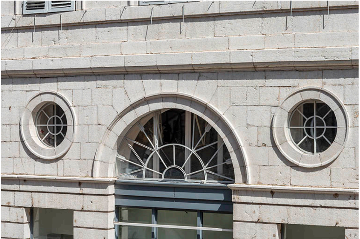
Façade antérieure. Ouvertures de l'entresol.
