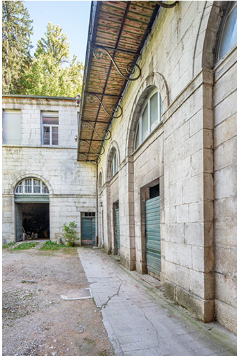
Vue de la cour depuis l'extrémité de l'allée couverte.
