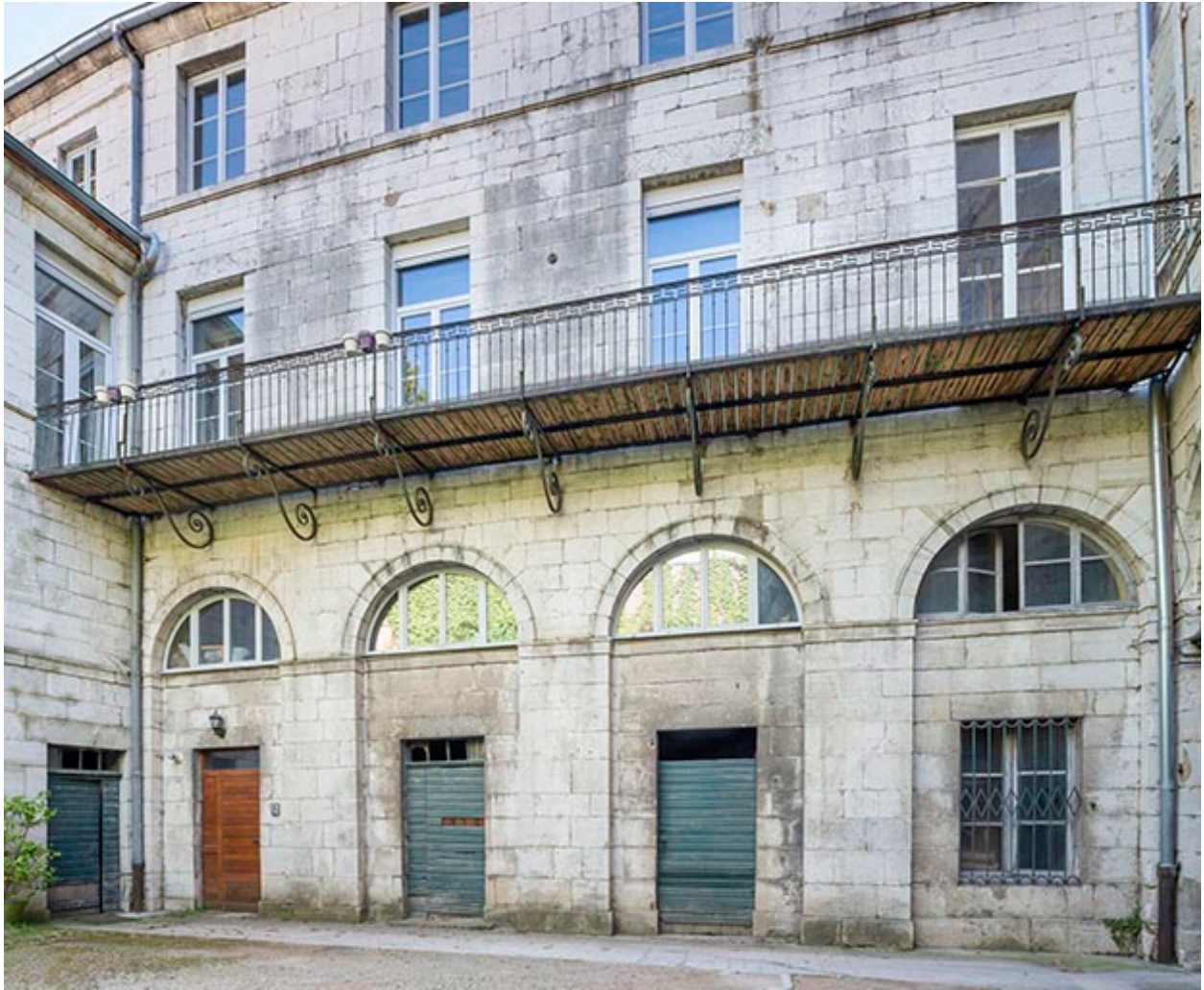
Façade de l'aile sud, depuis la cour.
