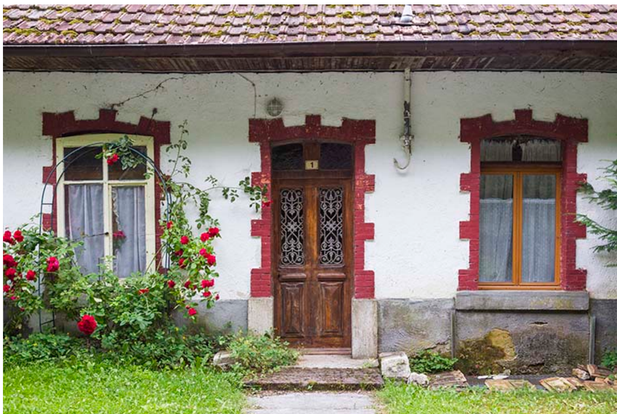
Logements d'ouvriers : façade antérieure du logement nord.
