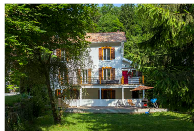
Logement de contremaître : façade postérieure. Phot. Yves Sancey IVR43_20132501510NUC2A
