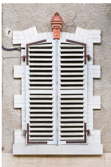
Logement patronal de 1900, façade antérieure : une fenêtre.
