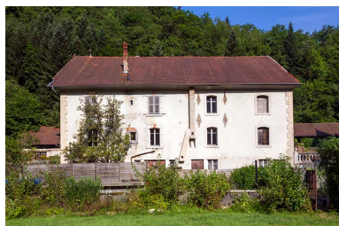
Logement patronal de 1900 : façade postérieure.
