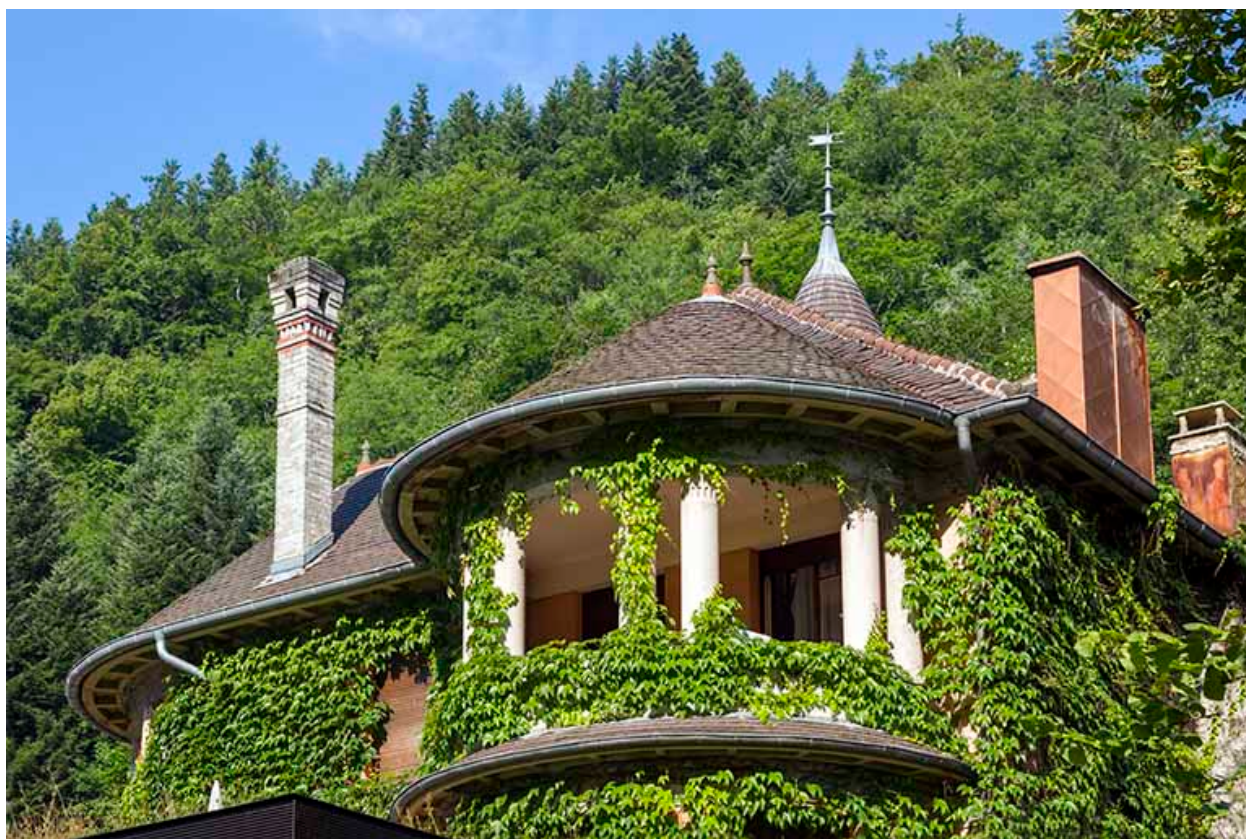
Logement patronal de 1931, façade postérieure : loggia.
