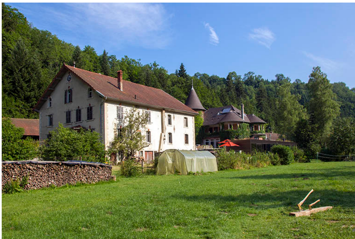
Vue d'ensemble du site, depuis le sud-est.
