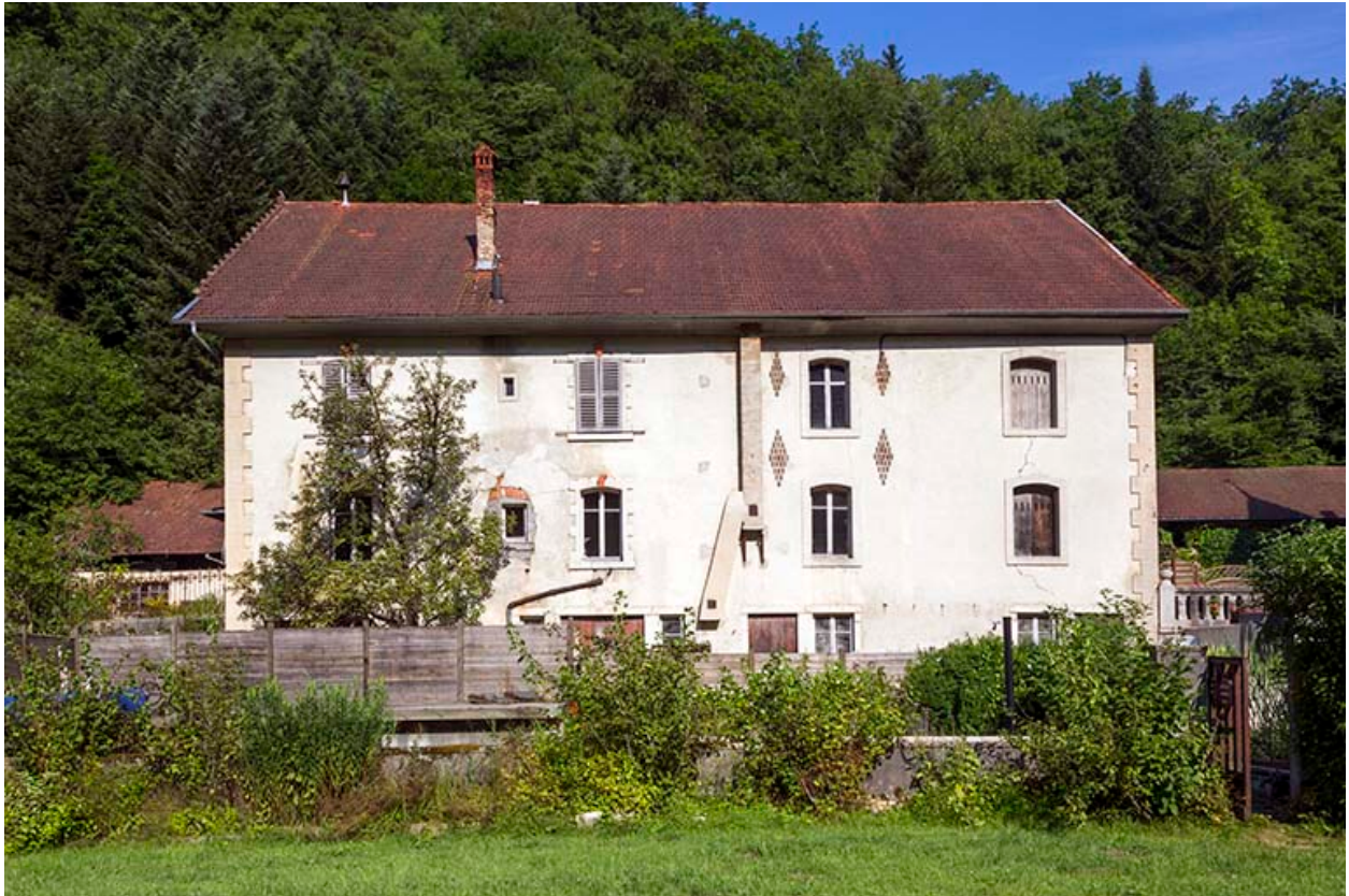
Logement patronal de 1900 : façade postérieure.
