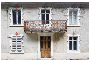
Logement patronal de 1900, façade antérieure : travées centrales.
