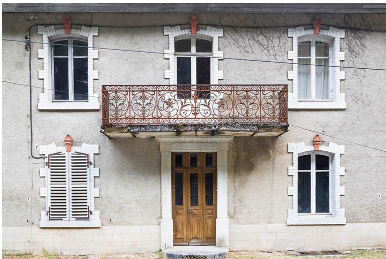
Logement patronal de 1900, façade antérieure : travées centrales.
