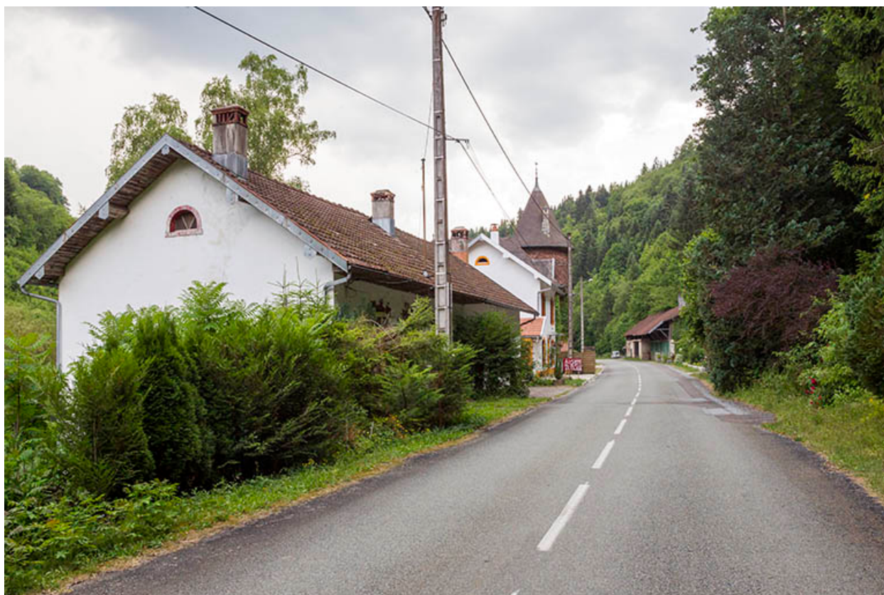
Vue d'ensemble du site, depuis le nord.
