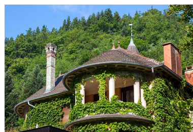
Logement patronal de 1931, façade postérieure : loggia. Phot. Yves Sancey IVR43_20132501509NUC2A
