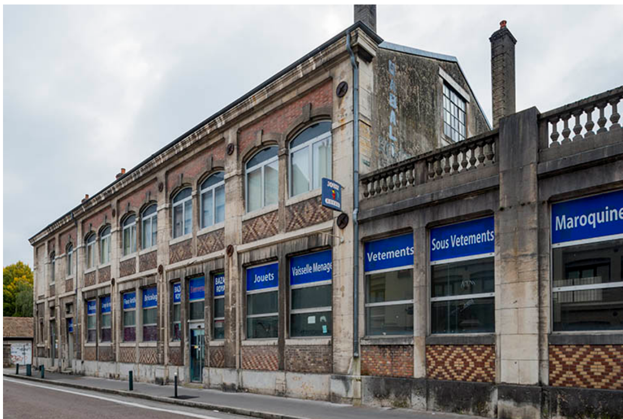
Vue rapprochée depuis le sud-ouest.
