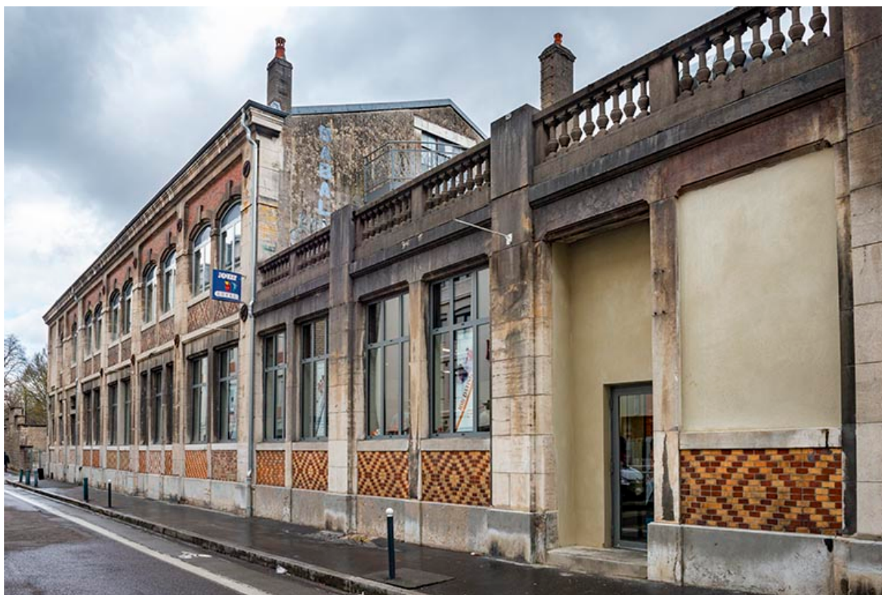
Vue rapprochée depuis le sud-ouest (après travaux).
