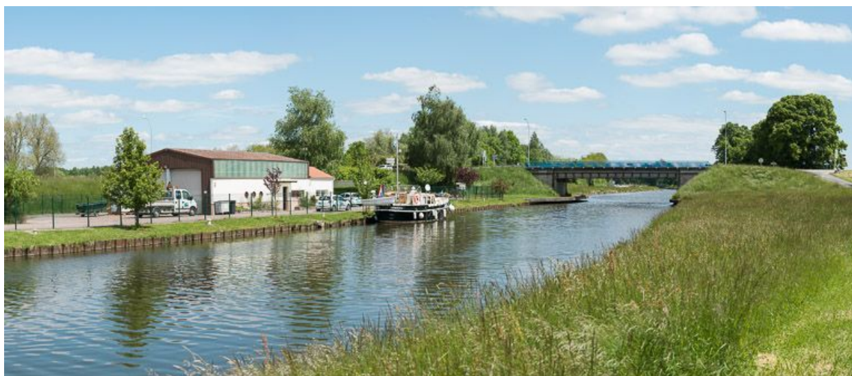
Vue d'ensemble du pont.
