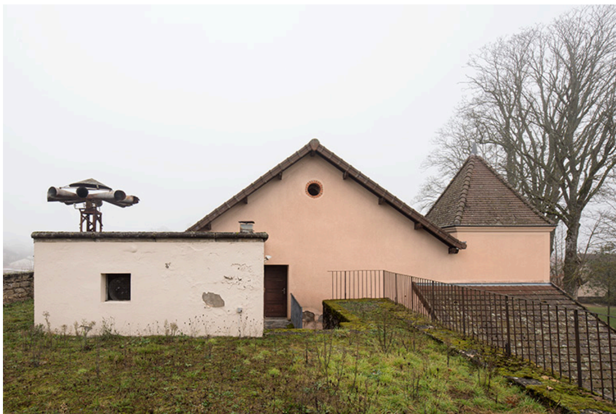
Façade latérale gauche, depuis le haut du bastion.
