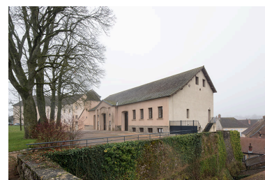
Vue d'ensemble, depuis le nord. Phot. Nicolas Waltefaugle IVR26_20257101122NUC4A
