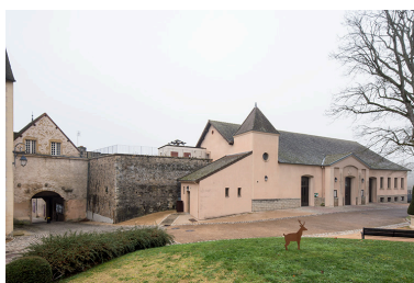
Vue d'ensemble, depuis le sud-est. Phot. Nicolas Waltefaugle IVR26_20257101119NUC4A
