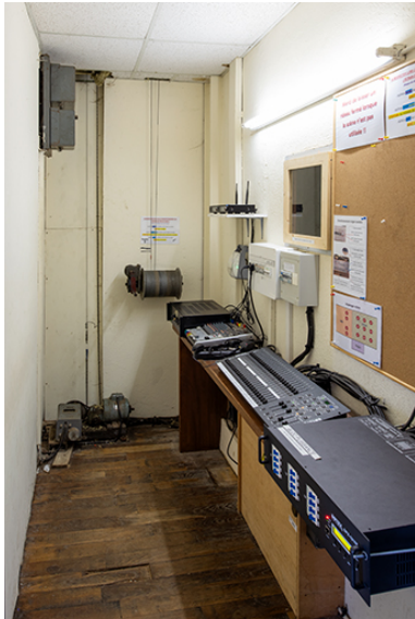
Régie. Au fond le système de montée et descente de l'écran.
