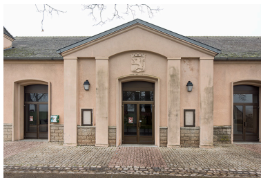
Façade antérieure : avant-corps central. Phot. Nicolas Waltefaugle IVR26_20257101121NUC4A
