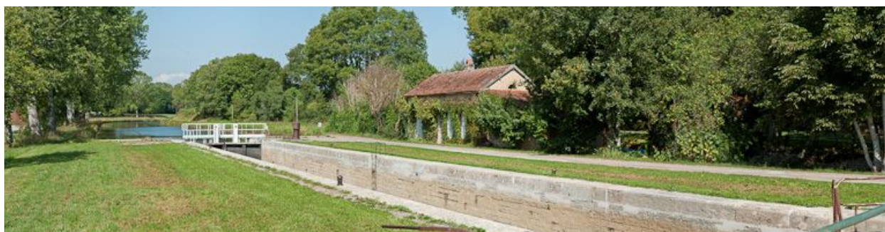
Vue du site d'écluse.
