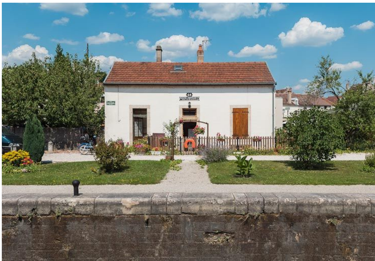
La maison éclésièr vue de face.
