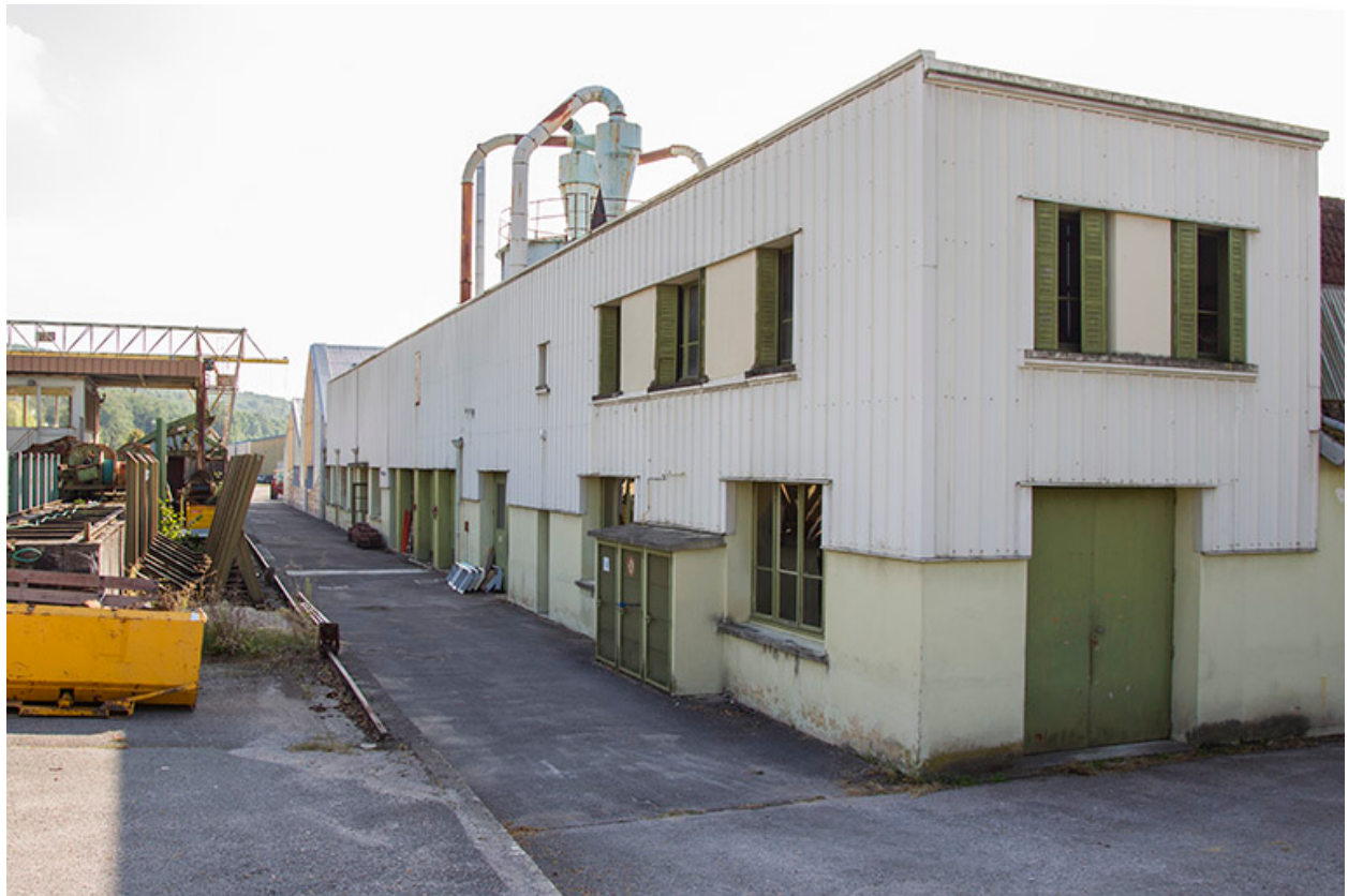
Atelier construction : façade antérieure.
