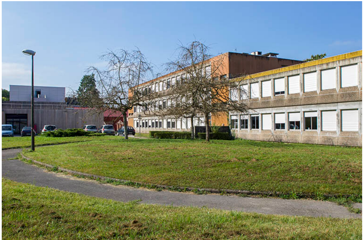
Internat : façade postérieure.
