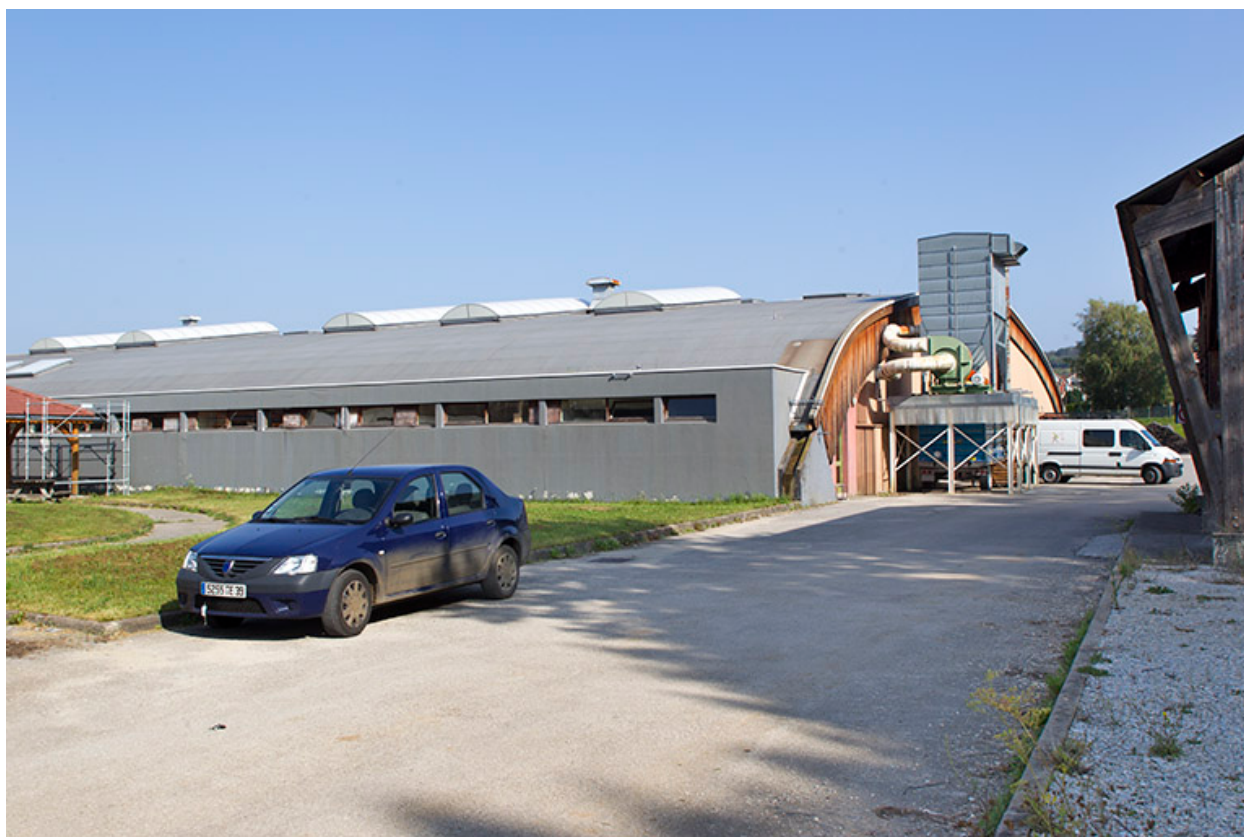
Atelier : façade nord.
