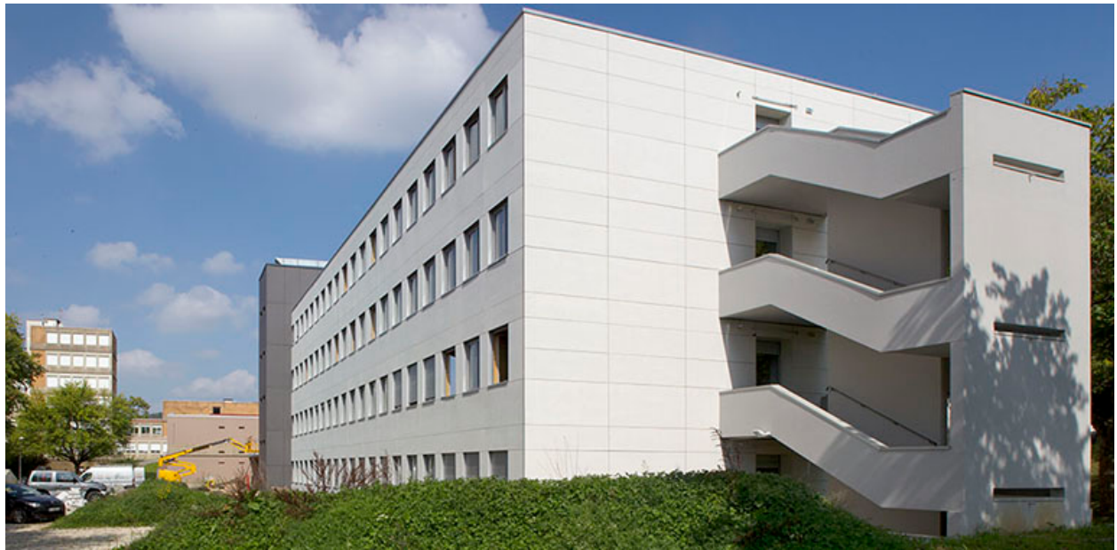
Internat : façade sud.
