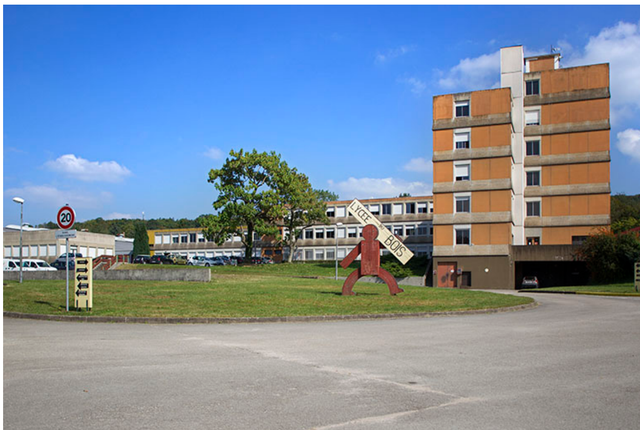
Vue générale avec, au premier plan, le bâtiment de l'administration.
