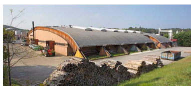
Atelier : couverture avec charpente. Phot. Sonia Dourlot IVR43_20143900635NUC2A
