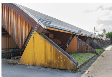
Atelier : couverture avec charpente, détail. Phot. Sonia Dourlot IVR43_20143900641NUC2A
