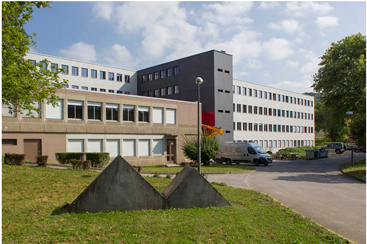
Internat : façade ouest.
