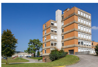
Administration et logements : façade ouest. Phot. Sonia Dourlot IVR43_20143900668NUC2A
