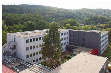
Internat : vue générale après restauration des façades. Phot. Sonia Dourlot IVR43_20143900672NUC2A
