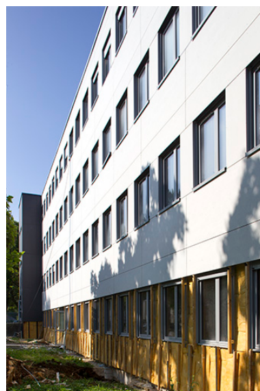
Internat : isolation des façades. Phot. Sonia Dourlot IVR43_20143900677NUC2A
