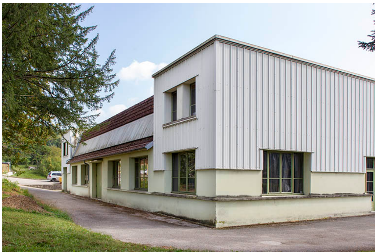
Atelier construction : façade postérieure.
