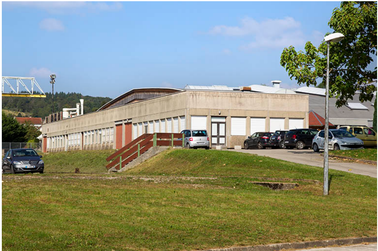
Atelier : salles de cours.
