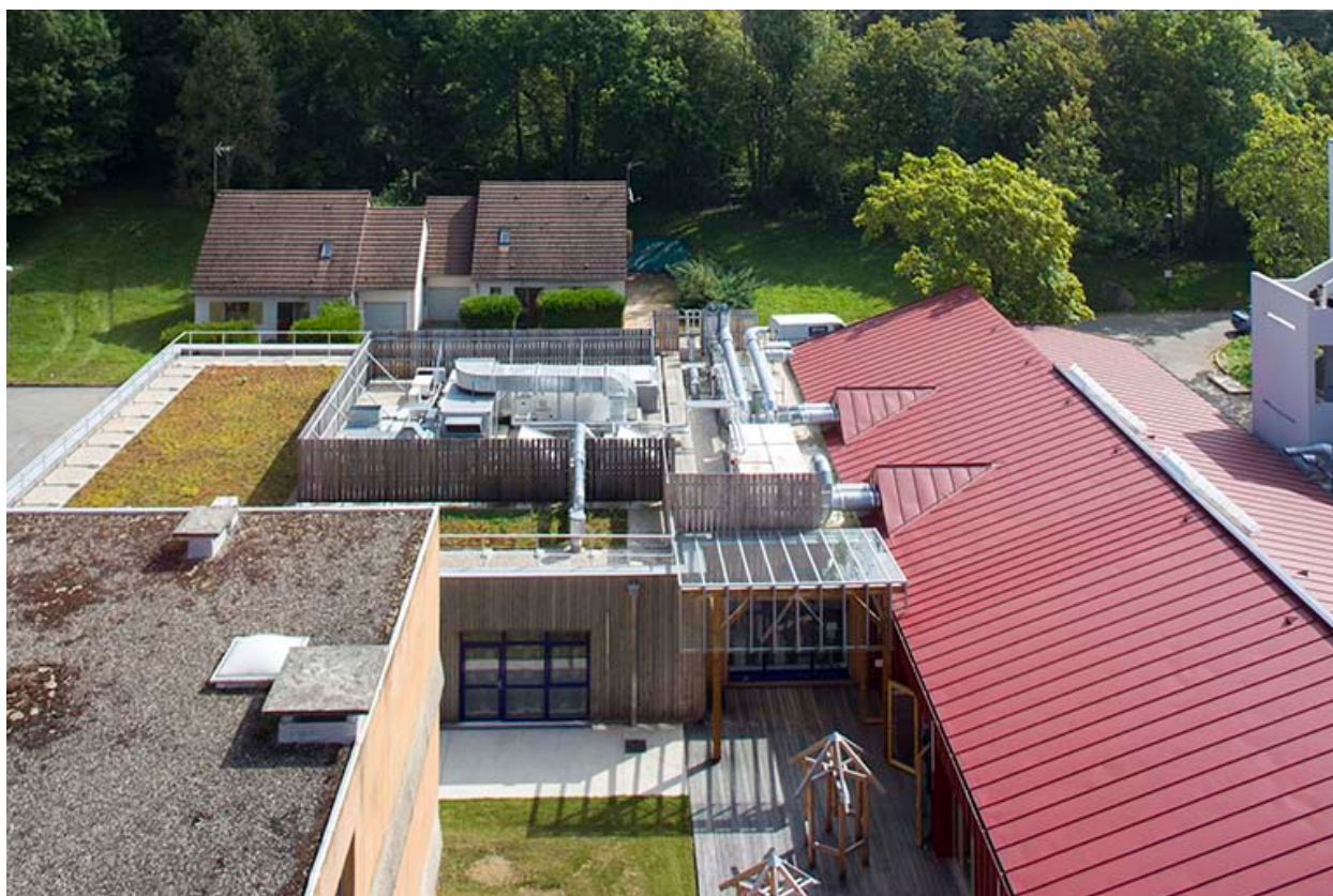
Restauration : cour intérieure.
