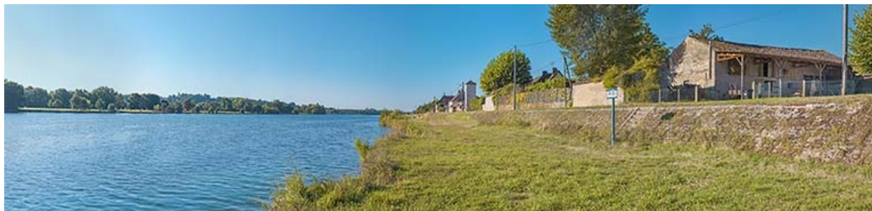
Perrés et escaliers au port de La Colonne.
